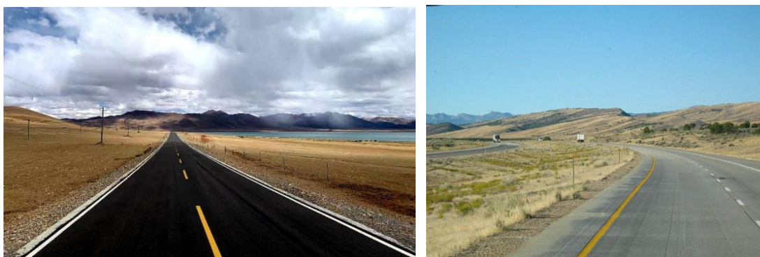
图 3-20 裸露边坡实例
