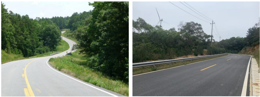
图 3-14 低路基浅挖方实例
