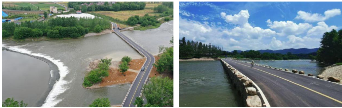
图 3-33 董家至洪家连接线建设工程漫水桥
