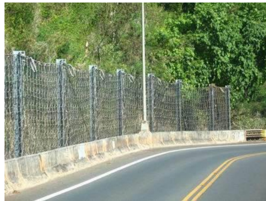
图 3-22 被动防护网防护
