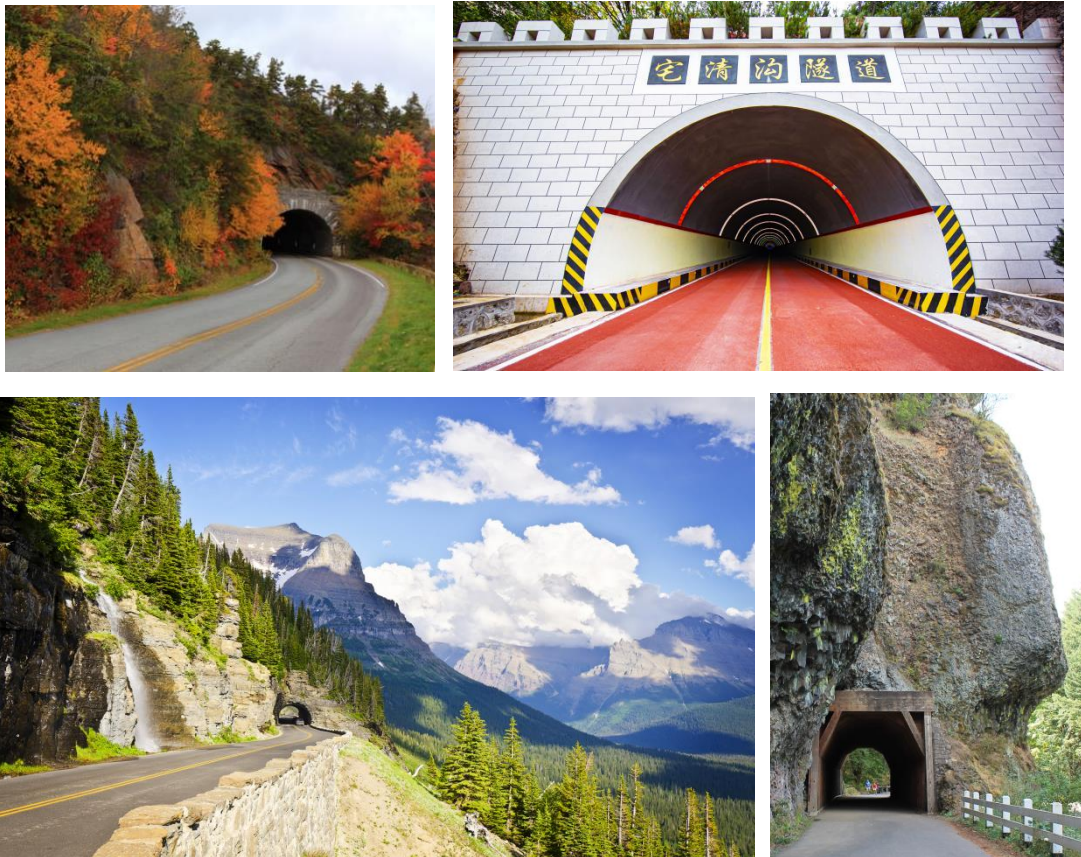
图 3-34 隧道洞门实例
