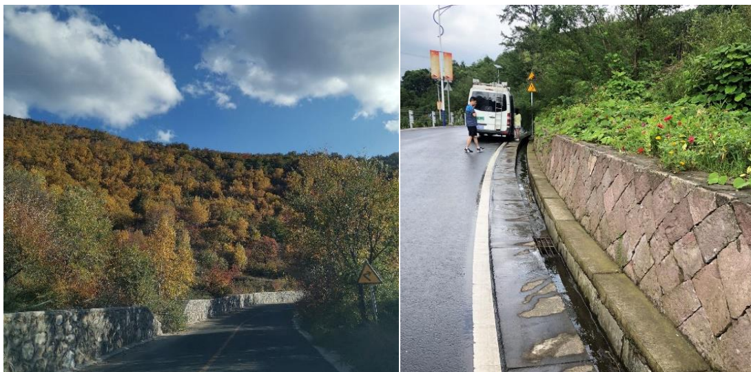
图 3-17 植物与低矮挡墙结合防护实例
