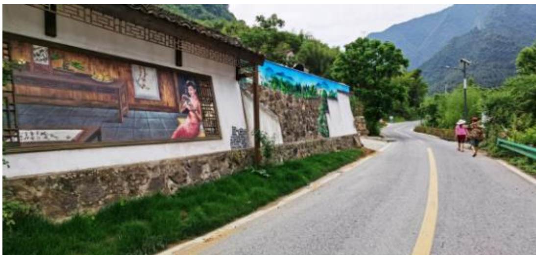
图 1-7 房屋外墙立面改造
