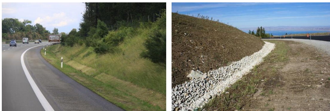
图 3-16 弧形坡面实例
