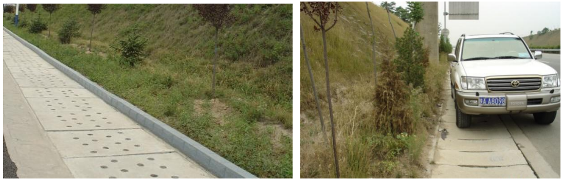
图 3-27 矩形圬工盖板边沟的应用
