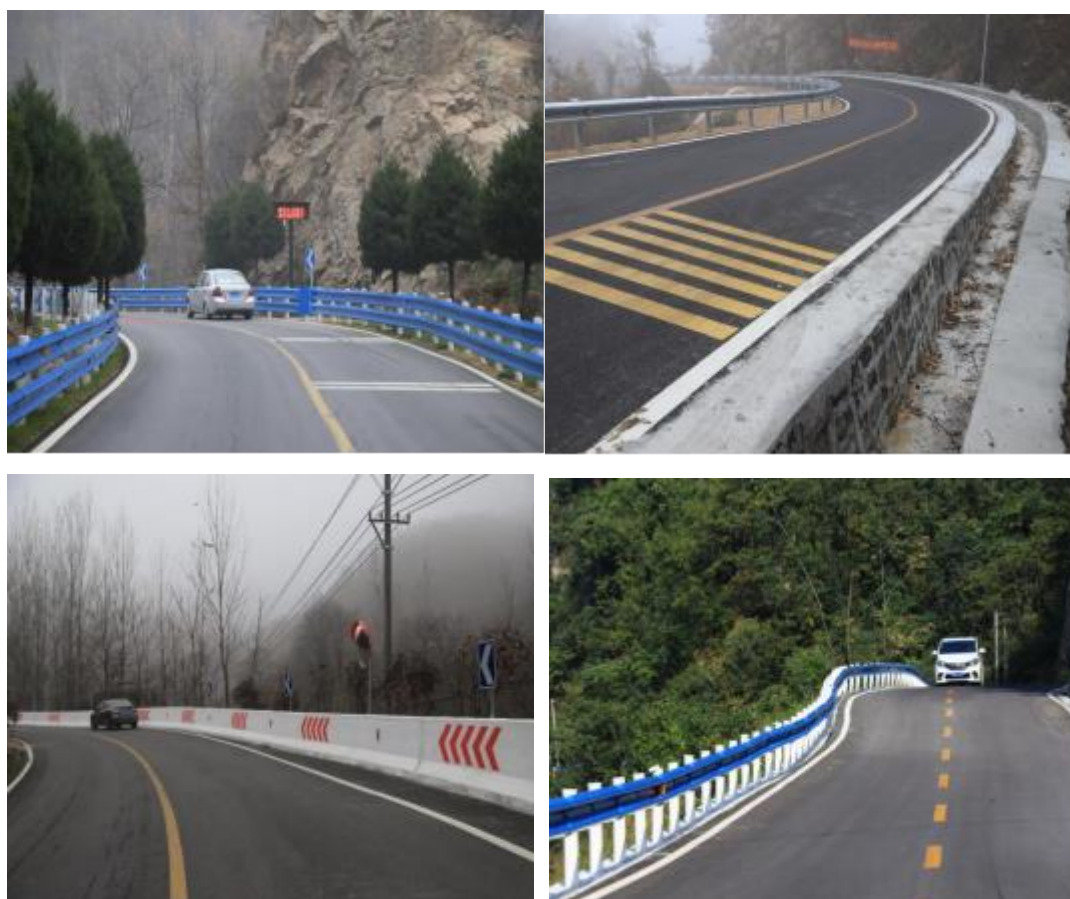
图 6-2 石林路安防工程
