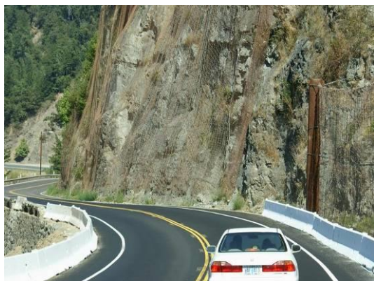
图 3-21 主动防护网防护
