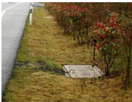
图 3-26 暗埋式生态边沟的应用
