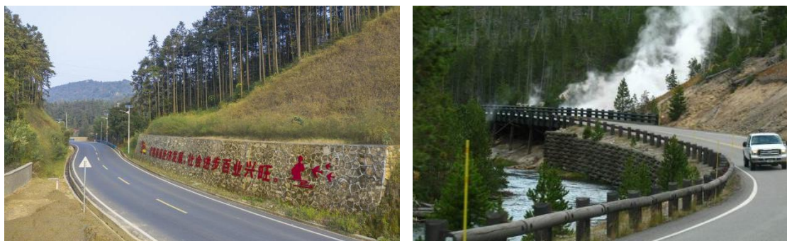
图 3-18 路堤挡墙实例
