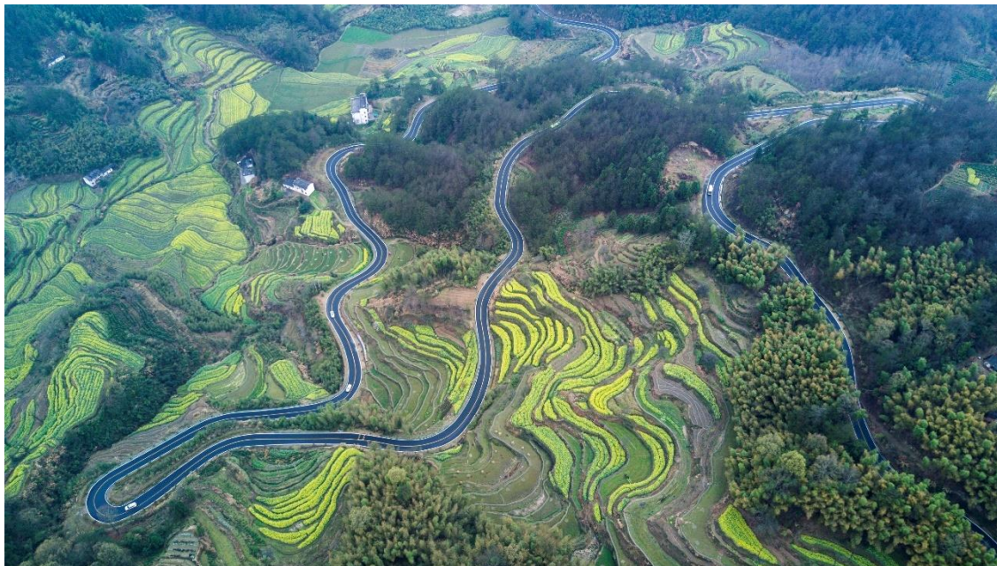
图 3-1 微丘布线农村公路实例图
