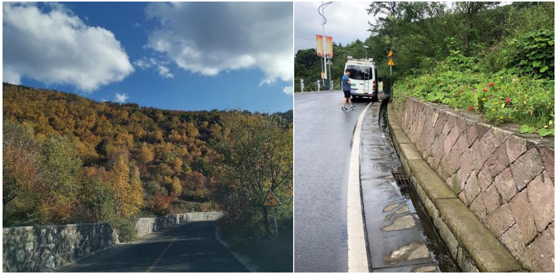
图 3-17 植物与低矮挡墙结合防护实例
