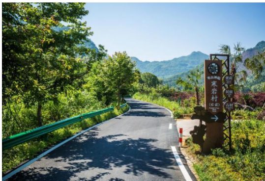
图 1-15 接线口硬化处理
