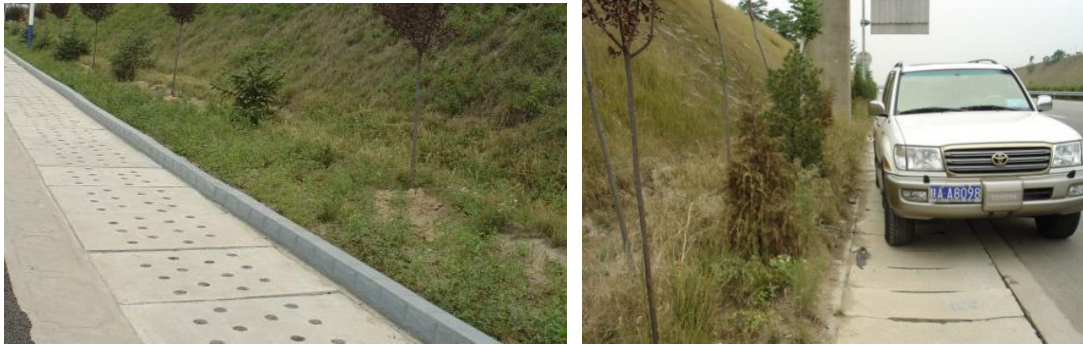
图 3-27 矩形圬工盖板边沟的应用
