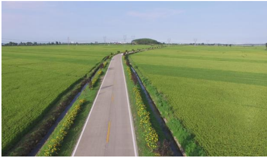
图 5-24 采用排水沟实现路田分家
