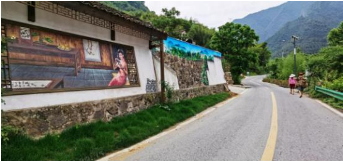
图 1-7 房屋外墙立面改造
