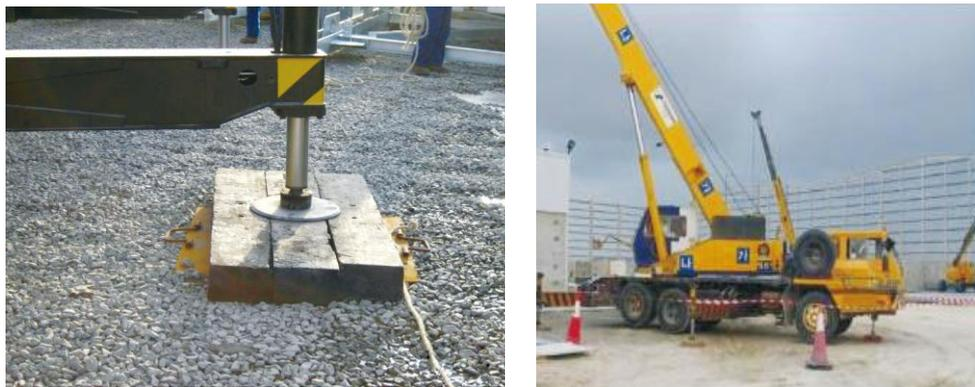
图 8.3-1 汽车吊作业示意图
