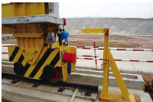
图 8.3-2 车挡及防撞缓冲装置
