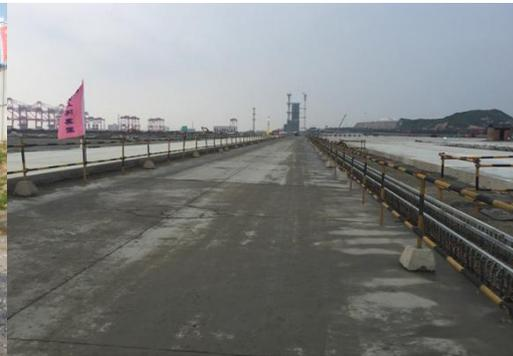
图 6.2-2 主通道硬化
