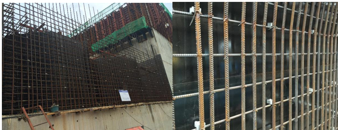
图 5.2-6 保护层垫块安装
