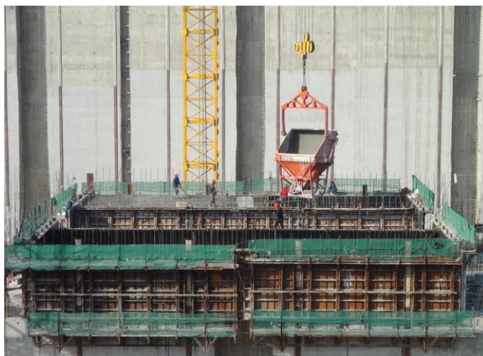
图 5.2-15 吊灌法浇筑闸室墙
