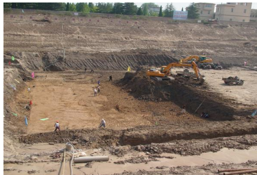
图 3.1-11 基坑开挖实图
