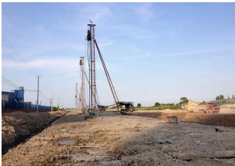
图 4.1-1 双向水泥搅拌桩施工
