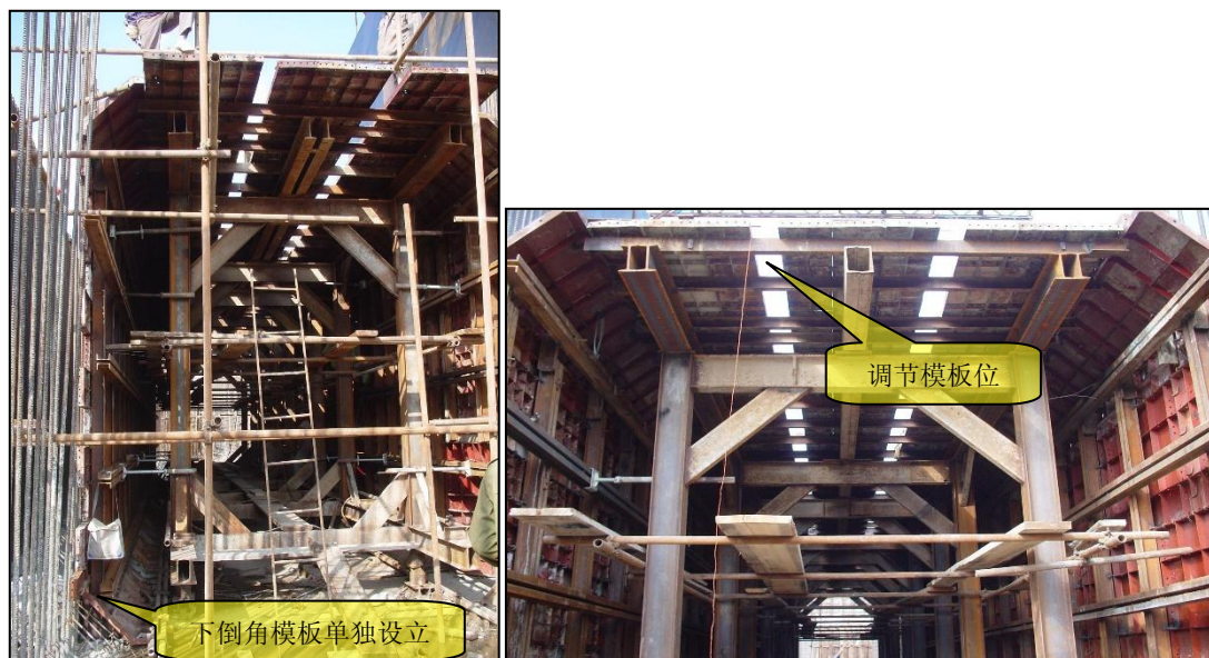
图 5.3-11 模架模板拼装图
