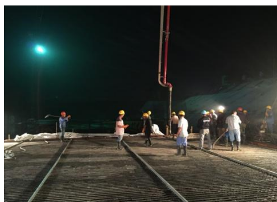
图 5.1-7 型钢控制顶面保护层
