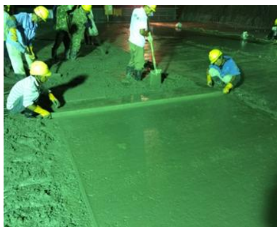
图 5.1-17 面层钢筋上部设置方钢导轨
