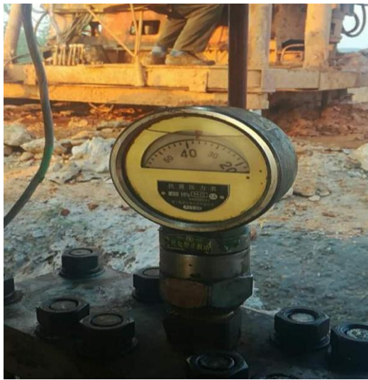
图 2.2-3 三重管法施工水压值
