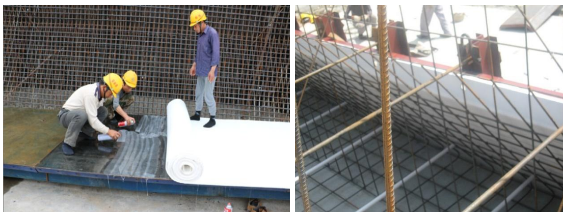
图 5.2-9 倒角模板粘贴透水模板布
