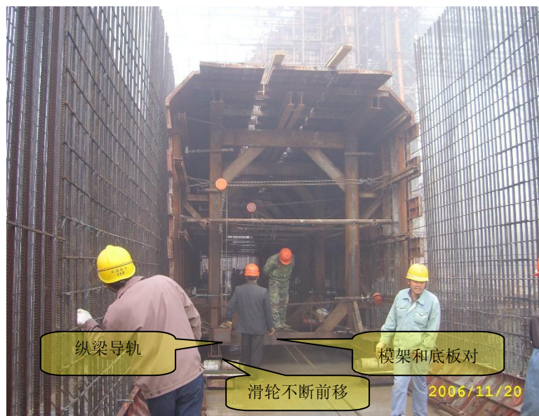
图 5.3-13 移动模架整体移动施工图
