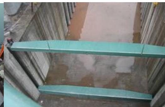
图 8.0-6 浮式叠梁检修闸门
