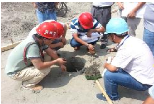
图 3.1-10 基底验槽
