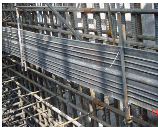
图 5.1-14 竖直止水带加固
