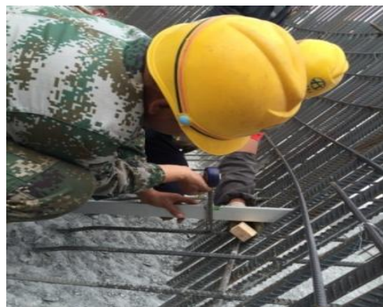
图 5.3-6 倒角钢筋斜面校验
