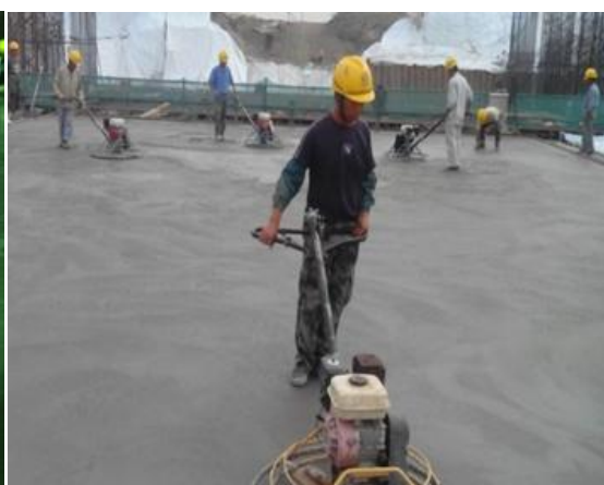
图 5.1-18 磨光机对表面收光
