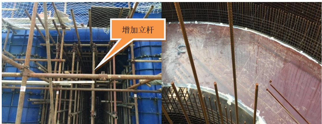
图 5.3-9 顶模衔接处增设立杆支撑
