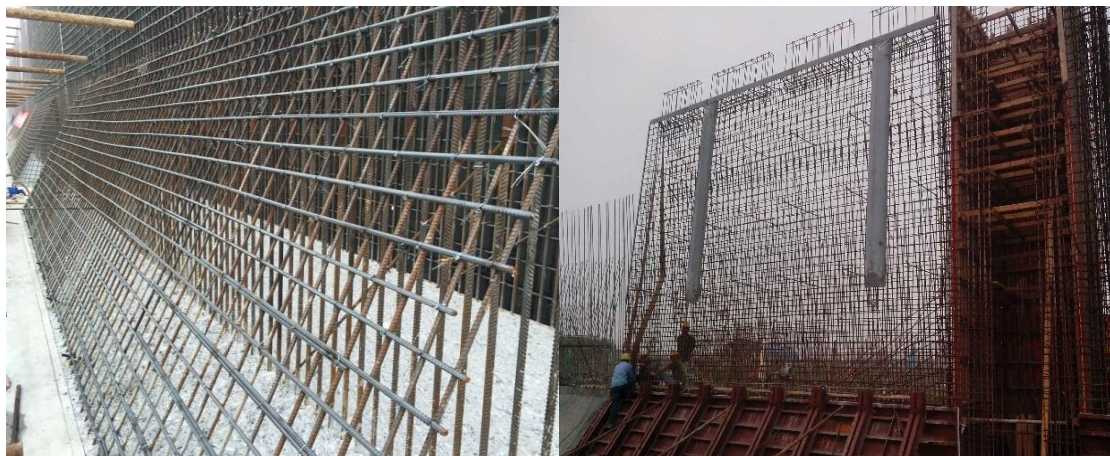
图 5.2-5 闸墙钢筋绑扎安装
