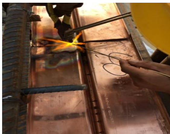
图 5.1-10 水平铜止水焊接
