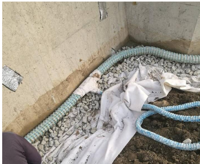
图 7.4-3 倒滤层施工
