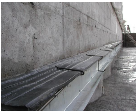
图 5.1-15 水平止水带加固
