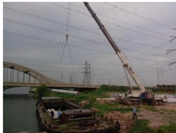
图 4.2-6 两头勾吊法吊运照片
