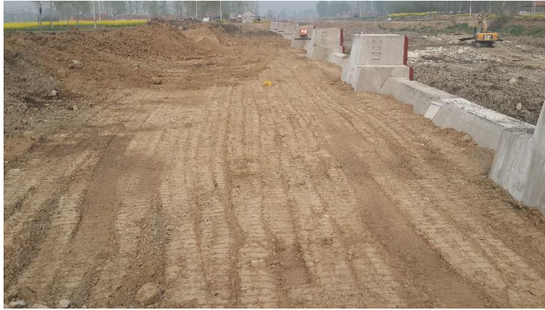
图 7.4-1 墙后工程土方回填
