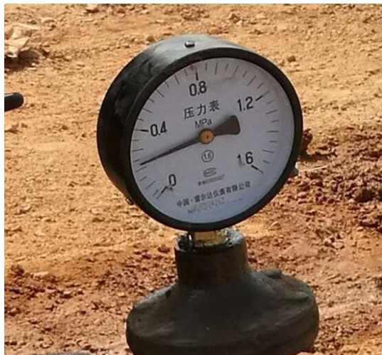
图 2.2-5 三重管法施工浆压值
