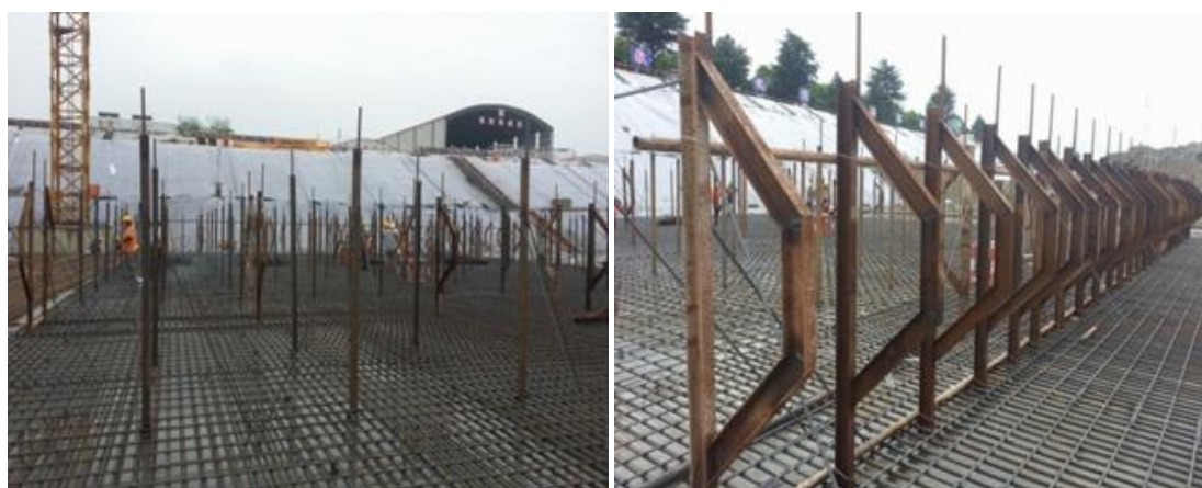
图 5.1-4 支撑与宽缝桁架
