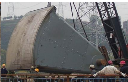
图 8.0-2 反向弧型阀门
