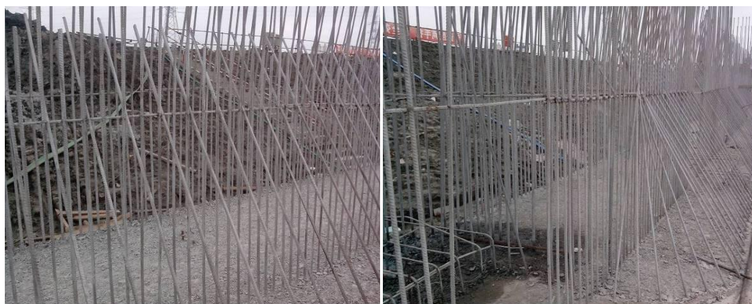
图 5.1-6 外露钢筋涂刷防腐涂层
