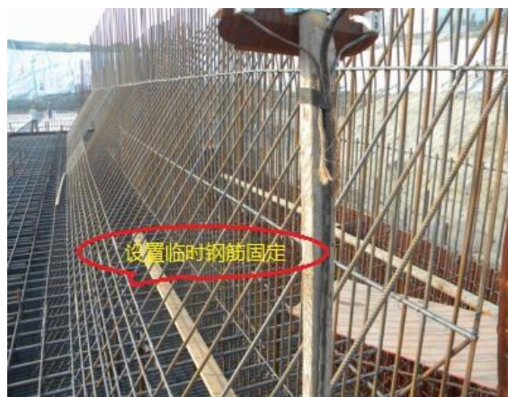
图 5.1-5 倒角预埋钢筋设置临时钢筋固定
