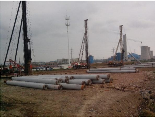
图 4.2-1 锤击法管桩施工
