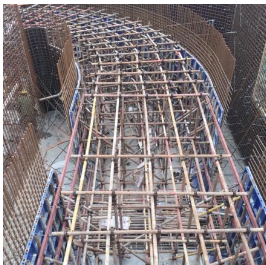
图 5.3-8 廊道满堂支架搭设
