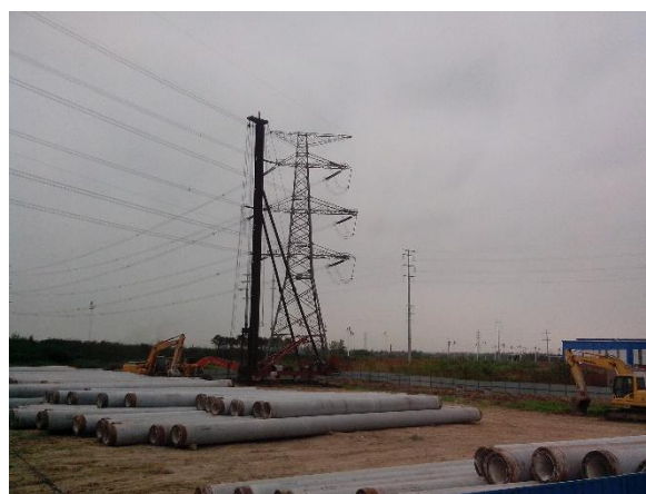
图 4.2-7 管桩现场堆放
