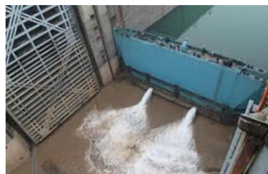
图 8.0-5 浮式检修门
