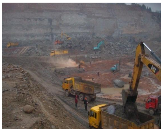
图 3.1-12 基坑石方开挖
