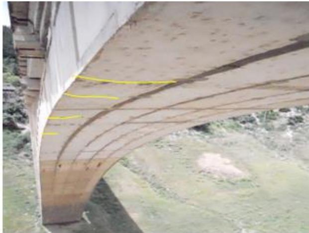
图10.3.2-6 拱顶横向裂缝
