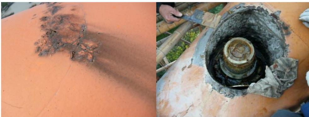
(a) 钢管拱肋油漆剥落
