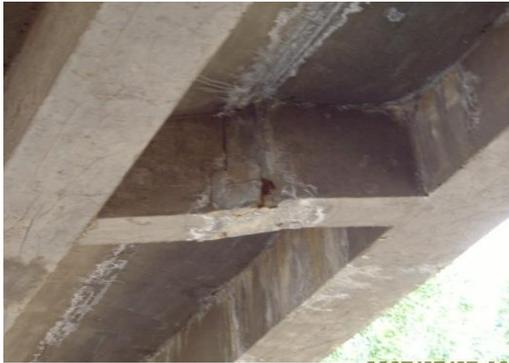
图6.3.2-10 湿接缝开裂、渗水、白析
