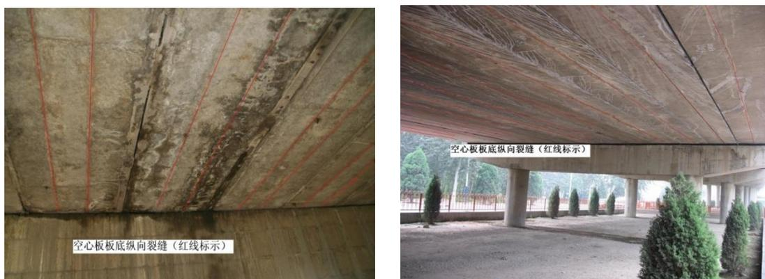
图6.2.2-3 空心板底面纵向裂缝
