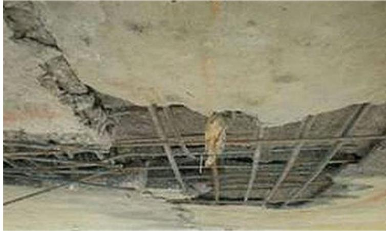
图6.4.2-5 箱梁底板崩裂
