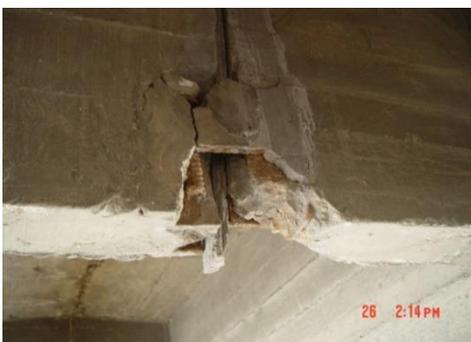
图6.3.2-6 横隔板混凝土破损、钢板外露
