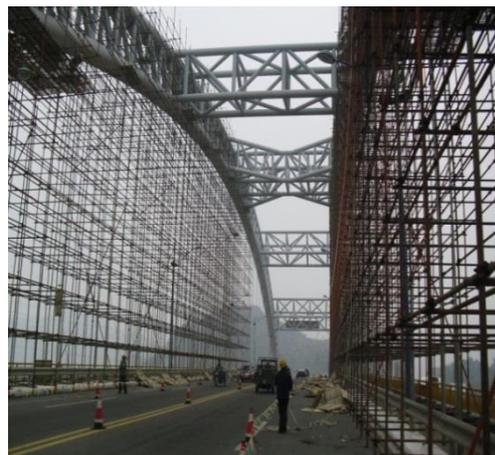
图 10.4.2-5 钢管拱桥更换吊杆
