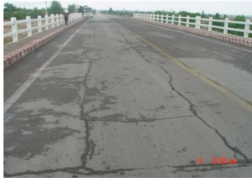
图6.3.2-11 桥面铺装延湿接缝开裂
