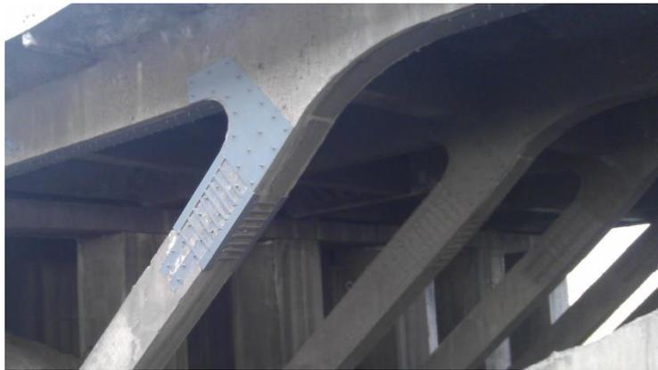
图10.3.3-7 节点粘贴钢板
