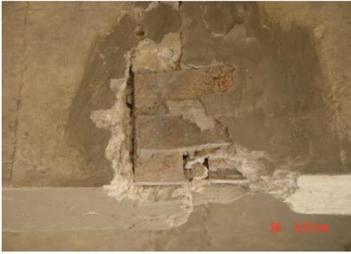
图6.3.2-8 横隔板钢板开焊图
