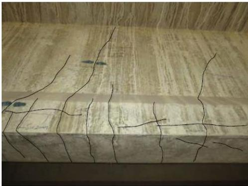
图6.3.2-3 腹板竖向裂缝照片
