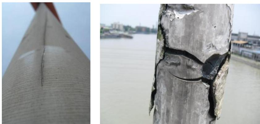
(c) 吊杆 PE 老化开裂
