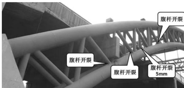
图10.4.2-1 拱肋钢管及节点开裂
