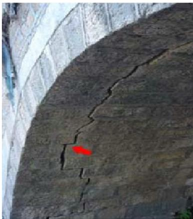
(b) 拱圈边缘的纵向开裂
