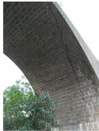
(c) 基础沉降导致的拱圈纵向开裂
