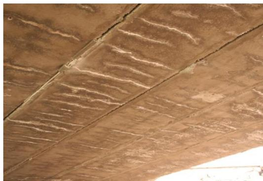
图6.2.2-2 空心板板底横向裂缝
