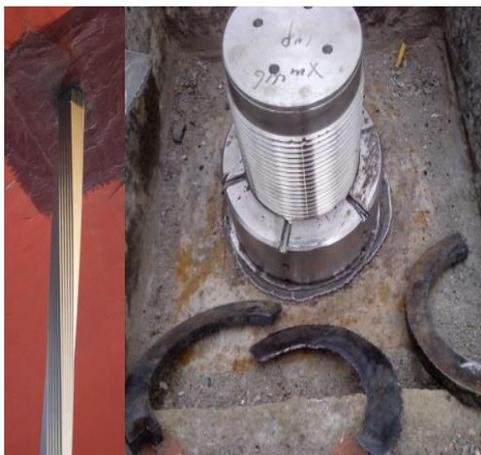
图 10.4.2-4 不锈钢吊杆及锚头
