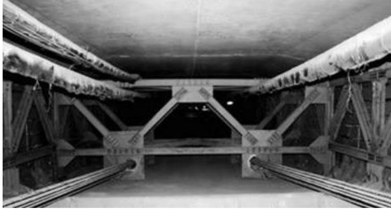
图6.4.3-10 钢桁架加固某箱梁图
