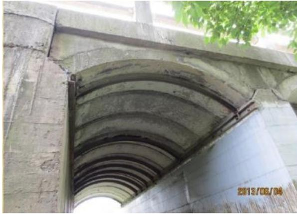
图10.2.3-2 纵向钢板条加固腹拱圈
