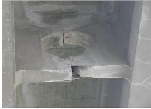
6.3.2-9 横隔板混凝土破损、露筋
