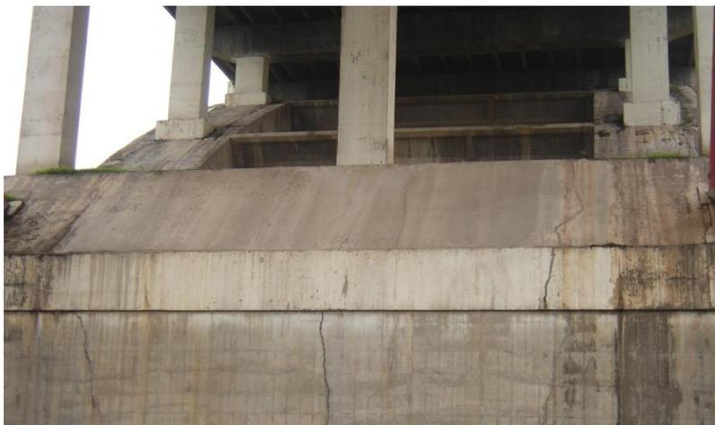
图10.3.2-7 肋拱桥拱座竖向开裂
