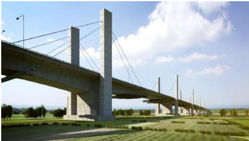
图6.4.3-13 连续刚构改造为斜拉体系效果图
