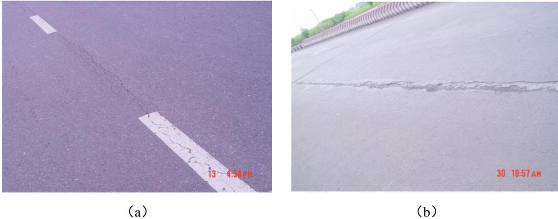
图6.2.2-5 铰缝开裂反射到桥面导致桥面铺装纵向开裂
