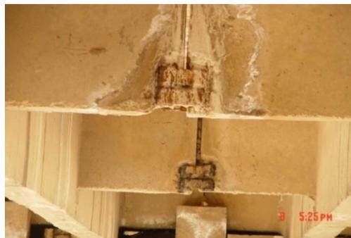
图6.3.2-7 横隔板钢板锈蚀
