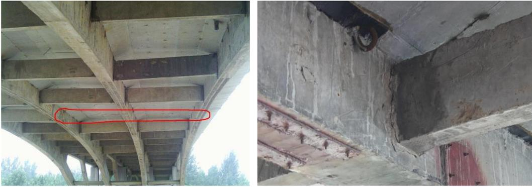
图10.3.2-5 横向联系开裂、脱落
