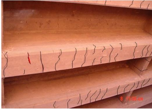
图6.3.2-5 T梁桥底板横向裂缝照片
