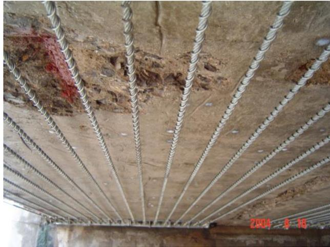
图6.2.3-2 板梁桥体外预应力加固示意图
