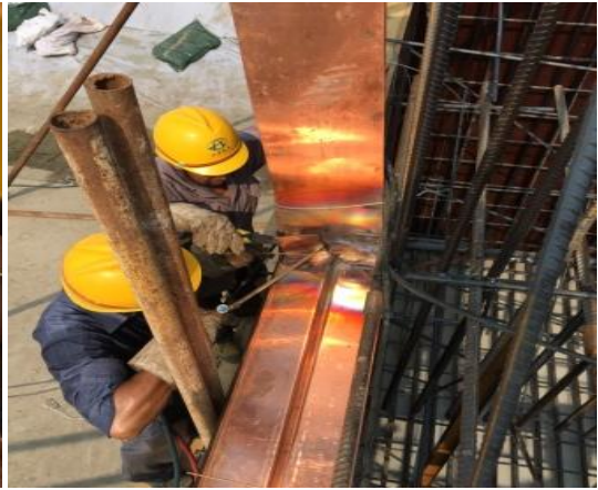
图 5.1-11 垂直铜止水焊接
