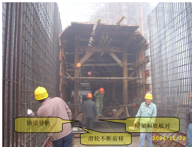
图 5.3-13 移动模架整体移动施工图
