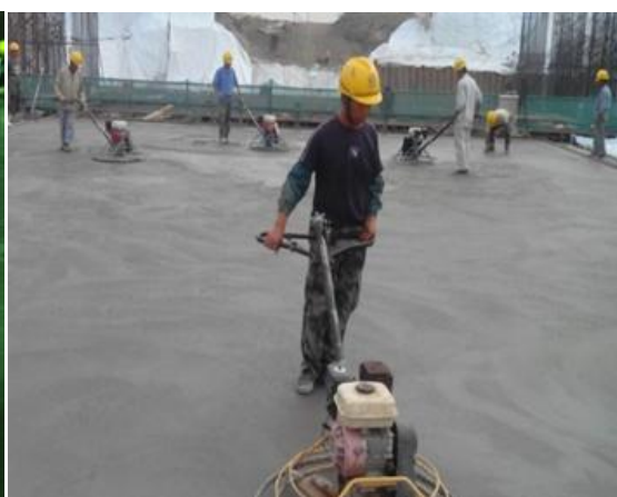
图 5.1-18 磨光机对表面收光
