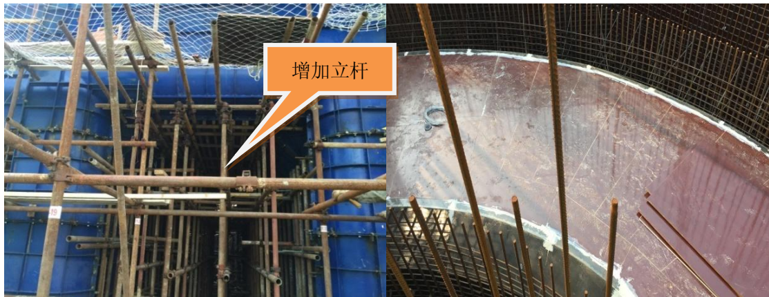
图 5.3-9 顶模衔接处增设立杆支撑
