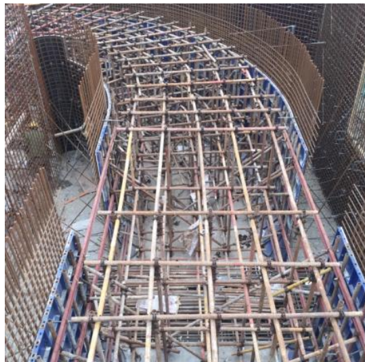
图 5.3-8 廊道满堂支架搭设
