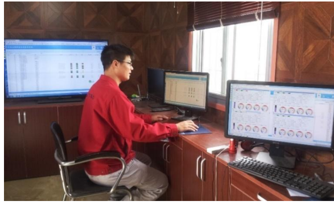
图 4.1-5 搅拌桩信息监控站
