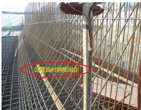
图 5.1-5 倒角预埋钢筋设置临时钢筋固定
