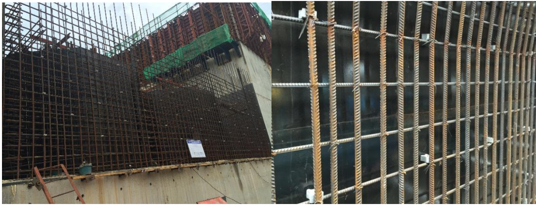
图 5.2-6 保护层垫块安装
