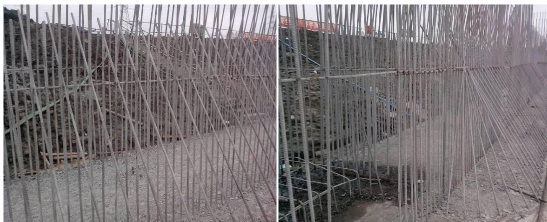
图 5.1-6 外露钢筋涂刷防腐涂层
