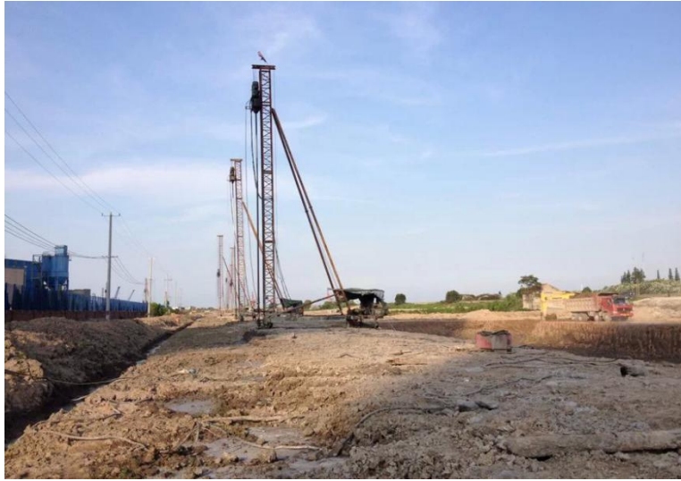
图 4.1-1 双向水泥搅拌桩施工
