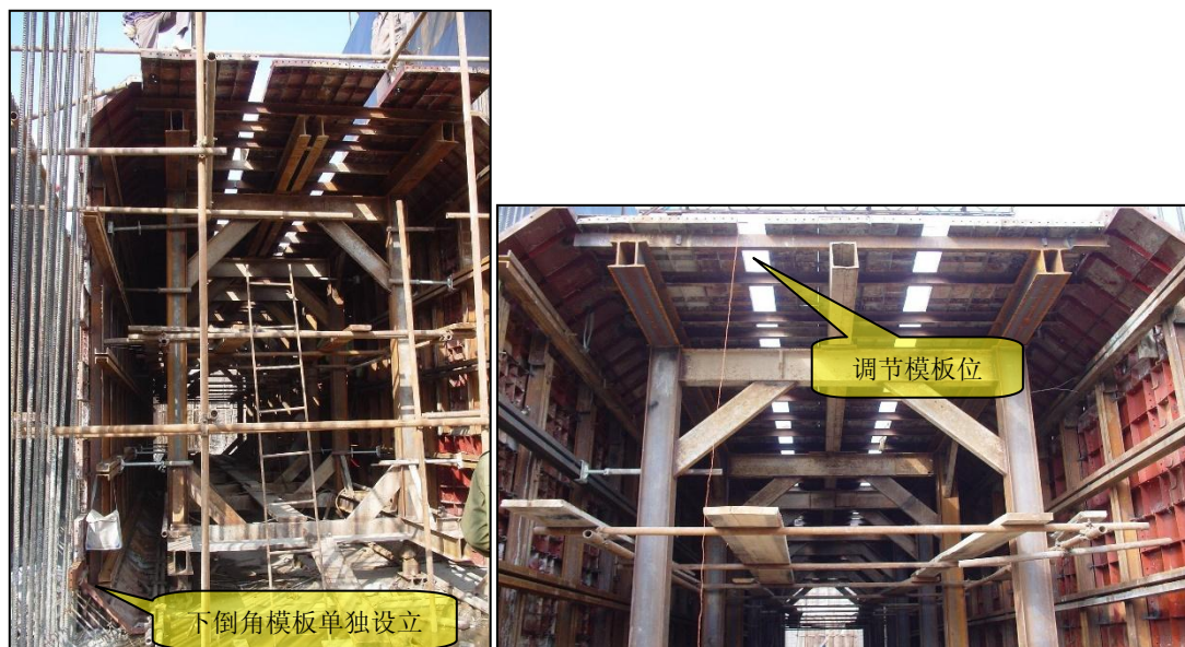
图 5.3-11 模架模板拼装图
