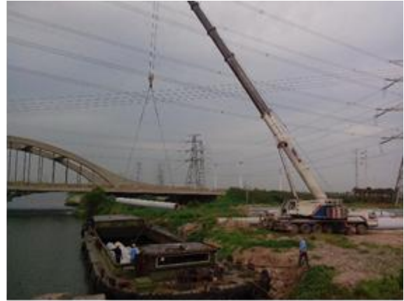
图 4.2-6 两头勾吊法吊运照片
