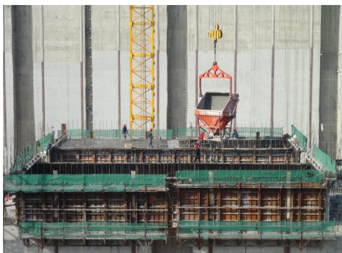
图 5.2-15 吊灌法浇筑闸室墙
