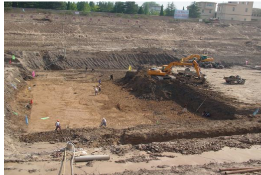
图 3.1-11 基坑开挖实景图
