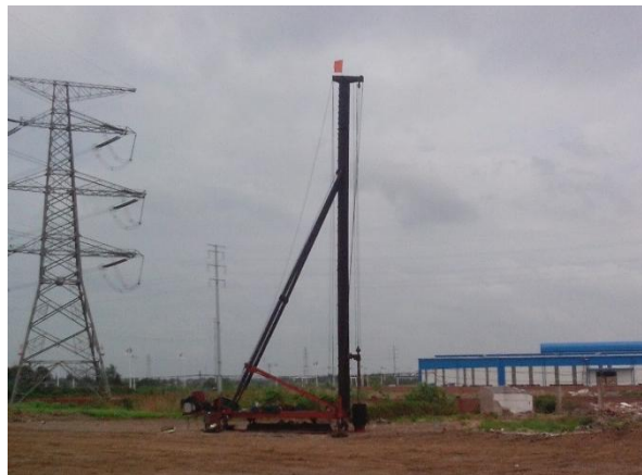
图 4.2-4 桩机现场拼装、就位
