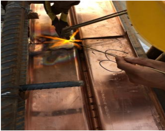
图 5.1-10 水平铜止水焊接
