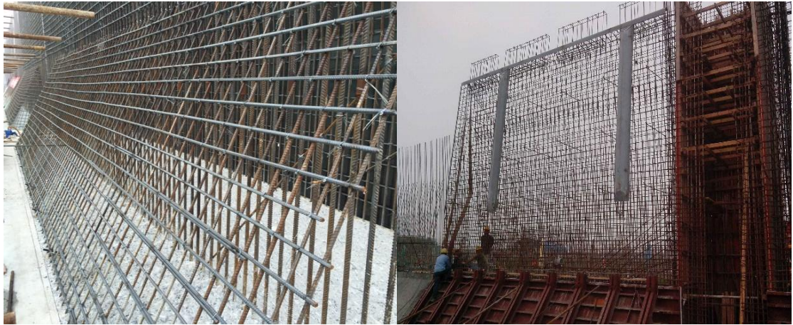
图 5.2-5 闸墙钢筋绑扎安装
