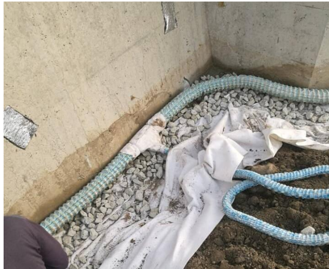
图 7.4-3 倒滤层施工
