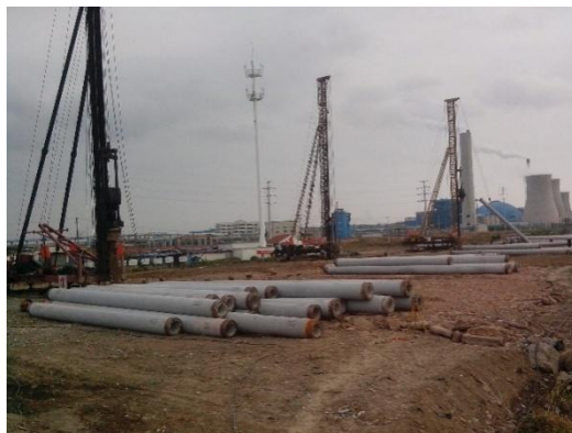
图 4.2-1 锤击法管桩施工
