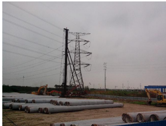
图 4.2-7 管桩现场堆放
