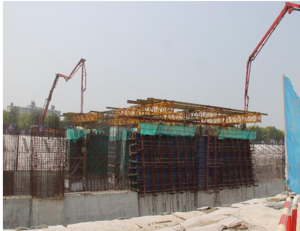
图 5.2-14 泵送法浇筑闸室墙
