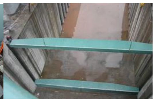
图 8.0-6 浮式叠梁检修闸门
