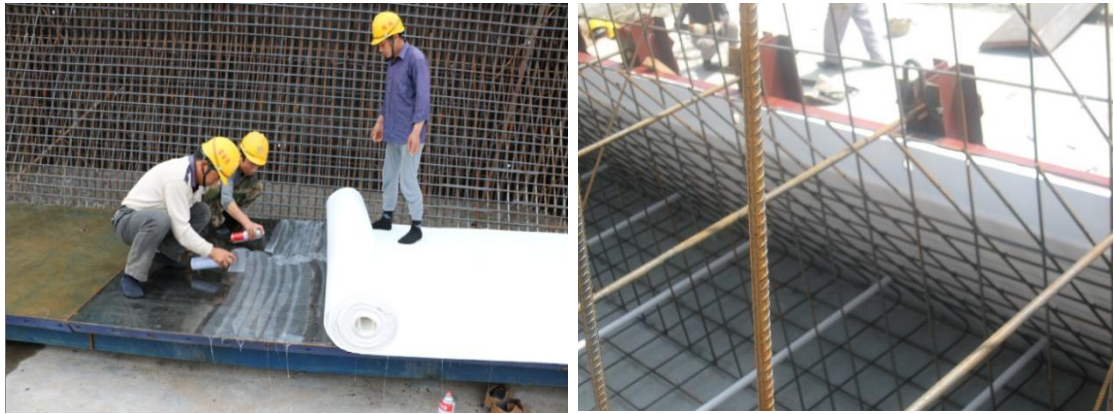
图 5.2-9 倒角模板粘贴透水模板布
