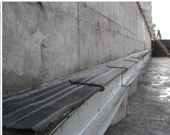
图 5.1-15 水平止水带加固
