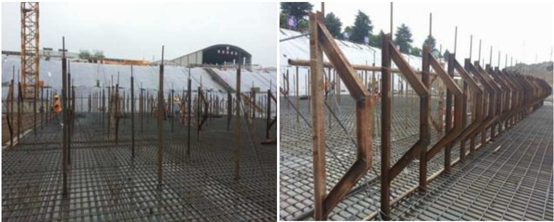
图 5.1-4 支撑与宽缝桁架
