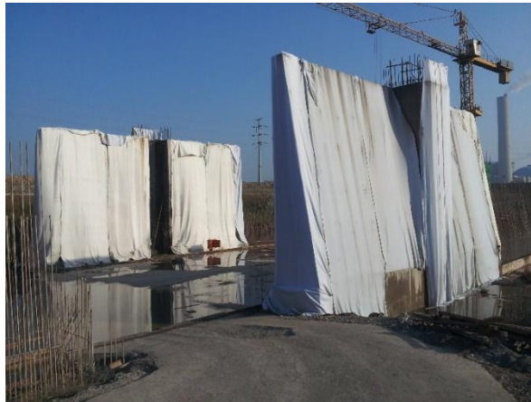
图 5.2-16 闸室墙成品养护
