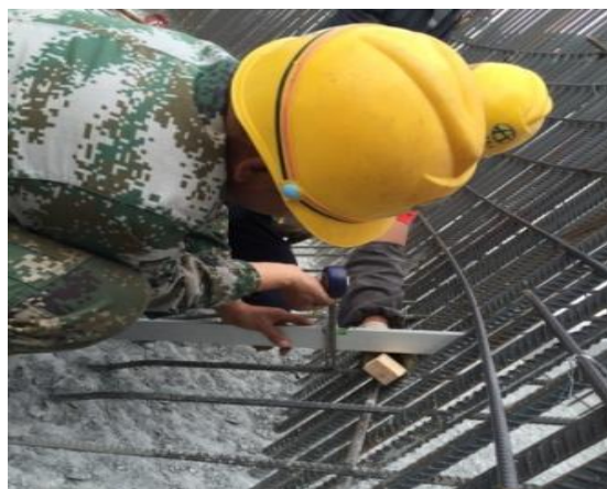
图 5.3-6 倒角钢筋斜面校验
