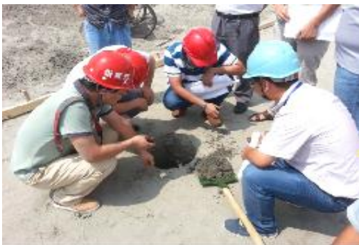
图 3.1-10 基底验槽
