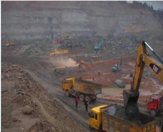
图 3.1-12 基坑石方开挖
