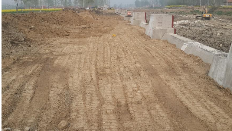
图 7.4-1 墙后工程土方回填
