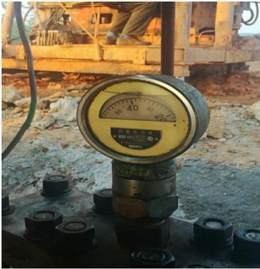
图 2.2-3 三重管法施工水压值
