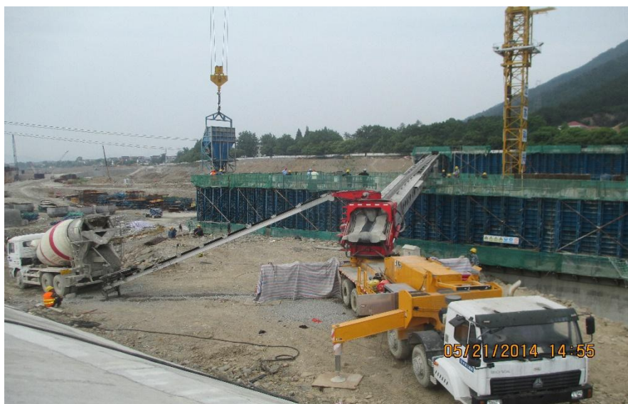
图 5.1-16 皮带机输送法混凝土浇筑
