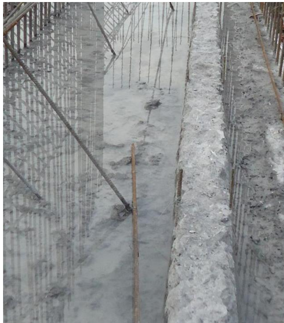
图 4.3-8 榫式凸槽实例
