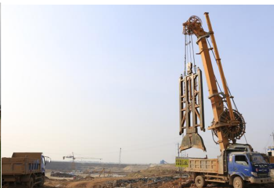
图 3.1-3 塑性混凝土防渗墙
