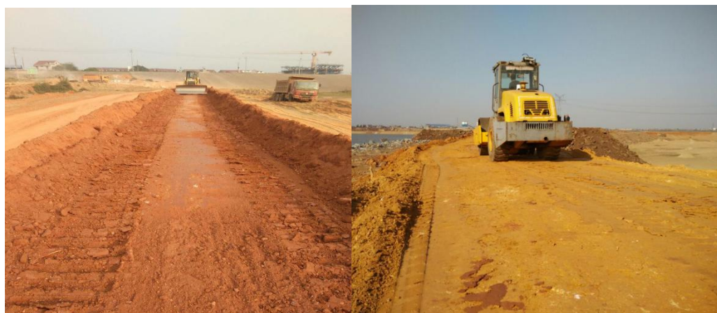
图3.1-4 黏土芯墙分层碾压
