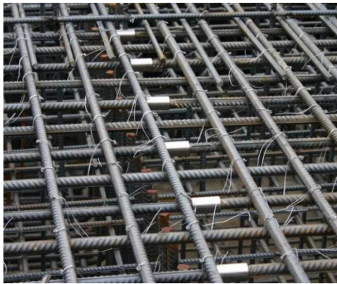
图 5.1-4 预埋锚筋支撑
