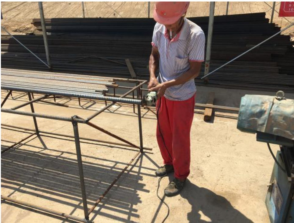
图 5.1-2 端头打磨
