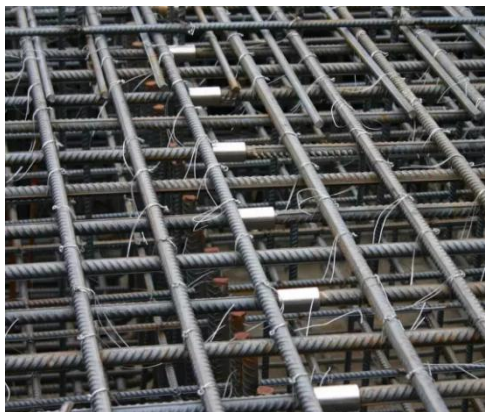
图 2.1-4 预埋锚筋支撑
