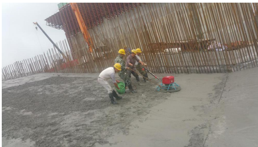
图 4.2-4 混凝土抹面机进行溢流面收光
