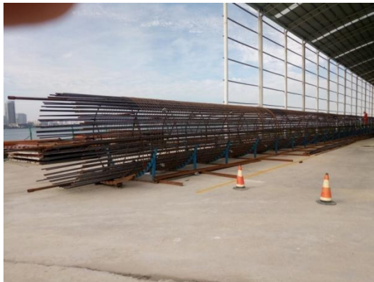
图 2.6-3 长线法制作钢筋笼
