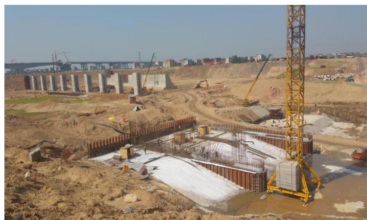
图 4.2-6 采用土工布进行覆盖养生
