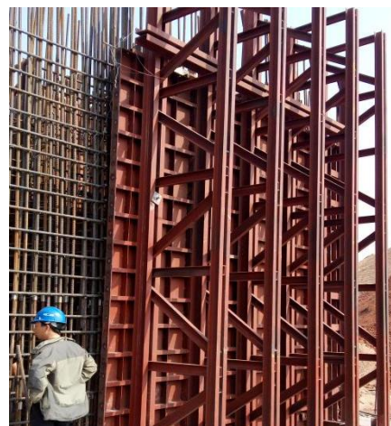
图 4.3-3 闸墩模板实例
