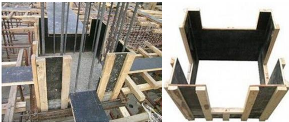
图 5.3-3 梁柱节点处定型模板
