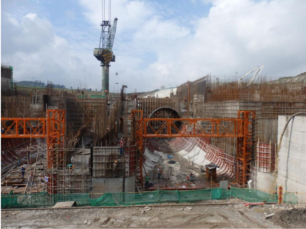
图 6.4-1 门槽台车安装埋件
