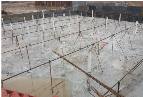
图 4.1-2 预埋锚筋支撑
