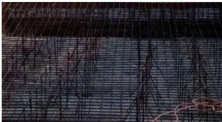
图 4.2-2 预埋锚筋支撑
