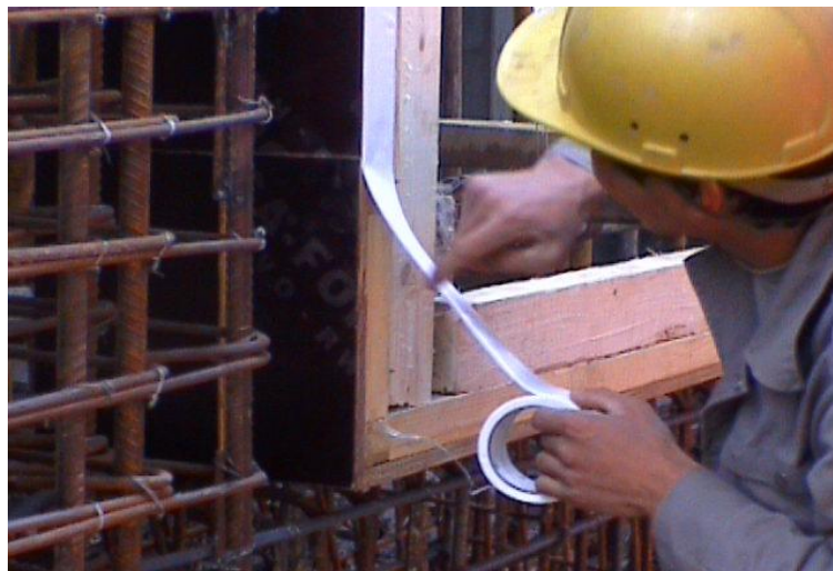
图 2.1-6 模板接缝处粘贴胶带
