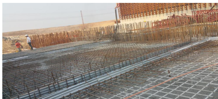
图 4.2-5 底坎预留槽采用收口网免拆除模板
