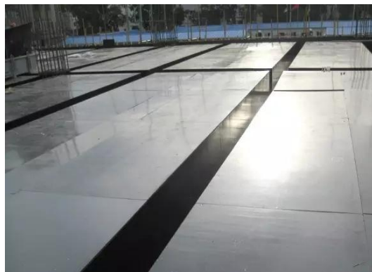
图 5.3-4 脱模剂涂刷均匀
