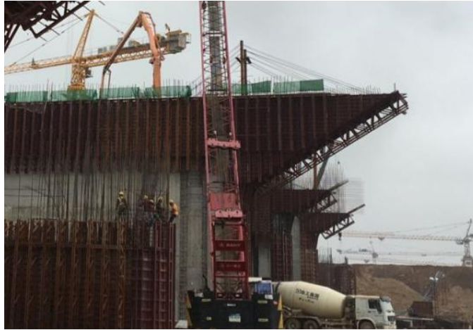
图 4.3-4 大型拉锚式模板支撑系统
