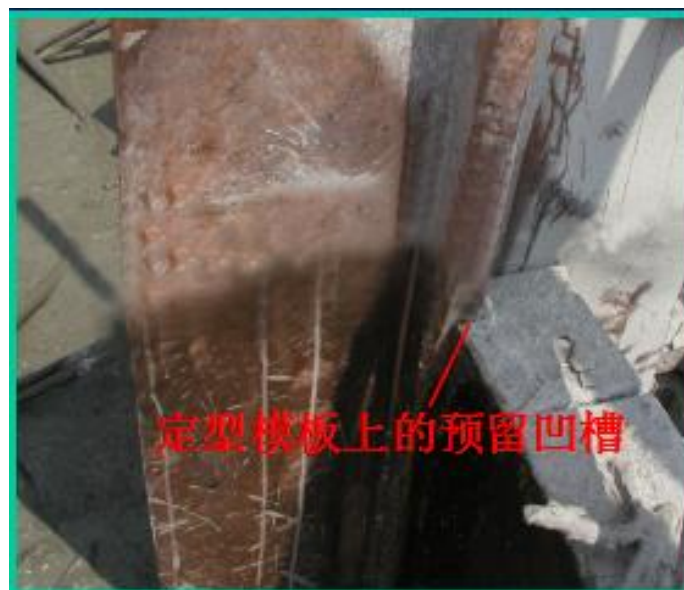
图 5.1-7 垂直止水加固措施
