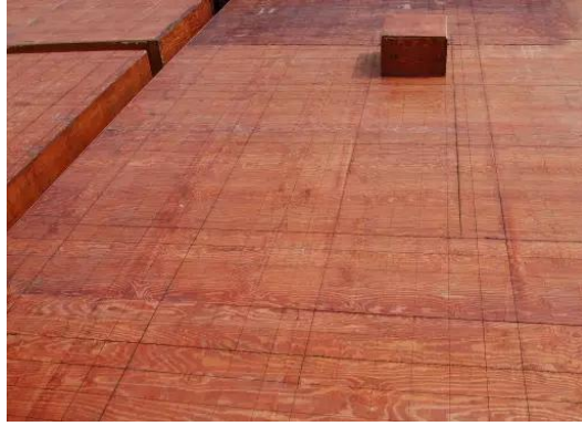
图 5.3-2 模板弹线定位钢筋
