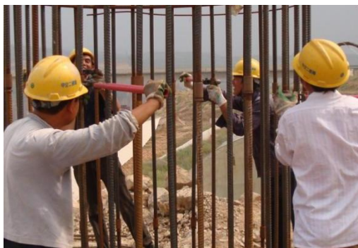
图 2.6-4 分节机械连接
