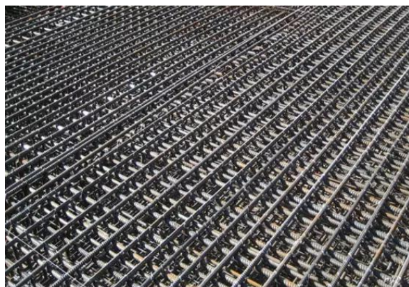
图 5.1-5 定位架控制安装精度
