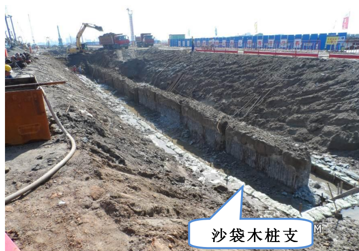
图 5.2-2 胸墙开挖支护
