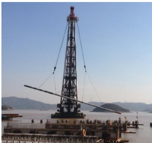
图 4.2-6 四点吊吊桩
