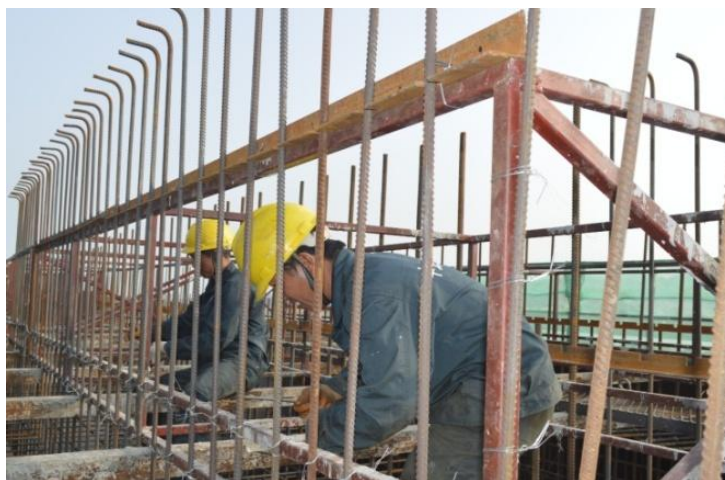
图 3.10-5 钢筋定位卡模和绑扎架
