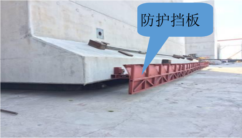
图 3.6-2 可伸缩安全附着式挡板实物示意图
