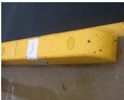
图 2.4-11 装配式护轮坎
