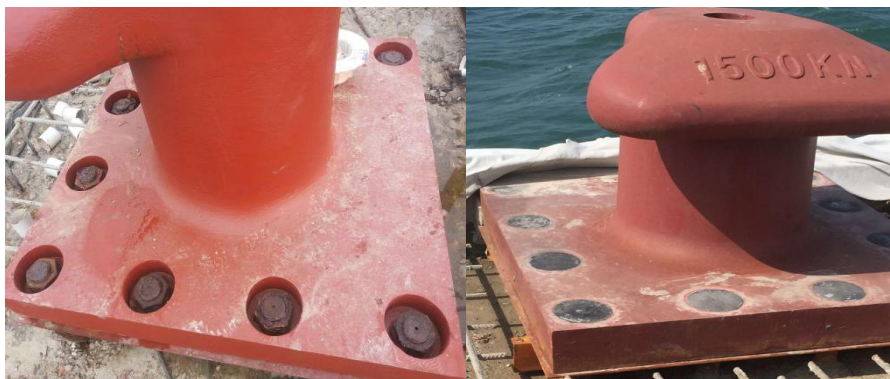
图 2.4-9 系船柱安装
