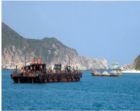
图 3.2-3 “开底驳+定位船运输船”基床抛石
