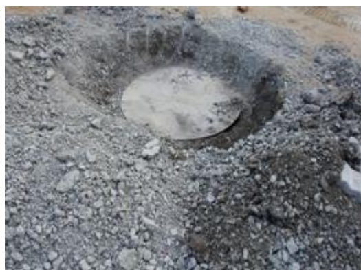
图 2.3-17 井图开挖
