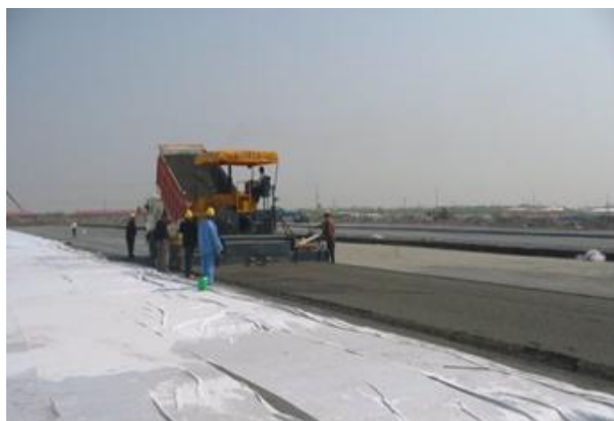
图 2.3-8 摊铺机摊铺水泥稳定层
