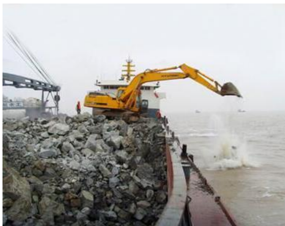
图 3.2-2 “反铲+定位船+运输船”基床抛石
