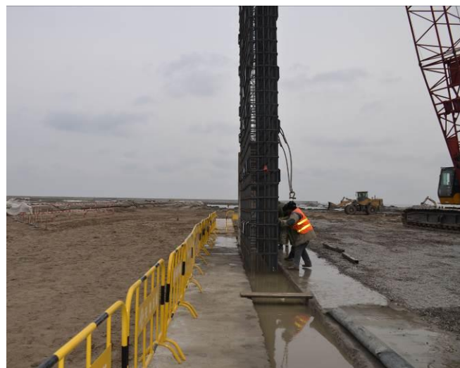
图 5.1-29 地连墙钢筋笼下放
