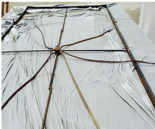
图 3.5-16 自动喷淋养护
