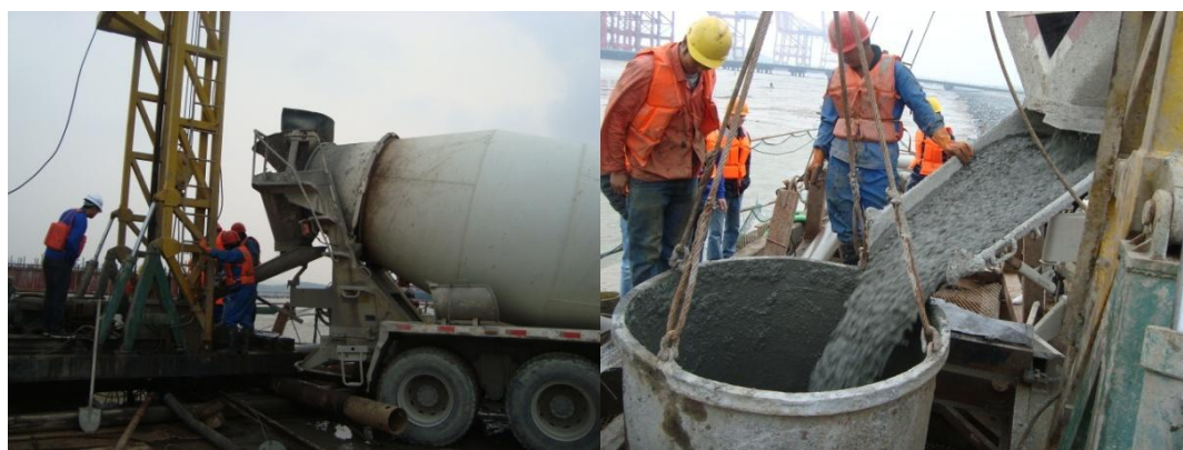
图 4.3-14 水下混凝土灌注
