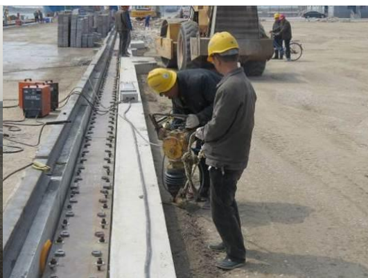
图 2.3-10 人工打夯密实处理
