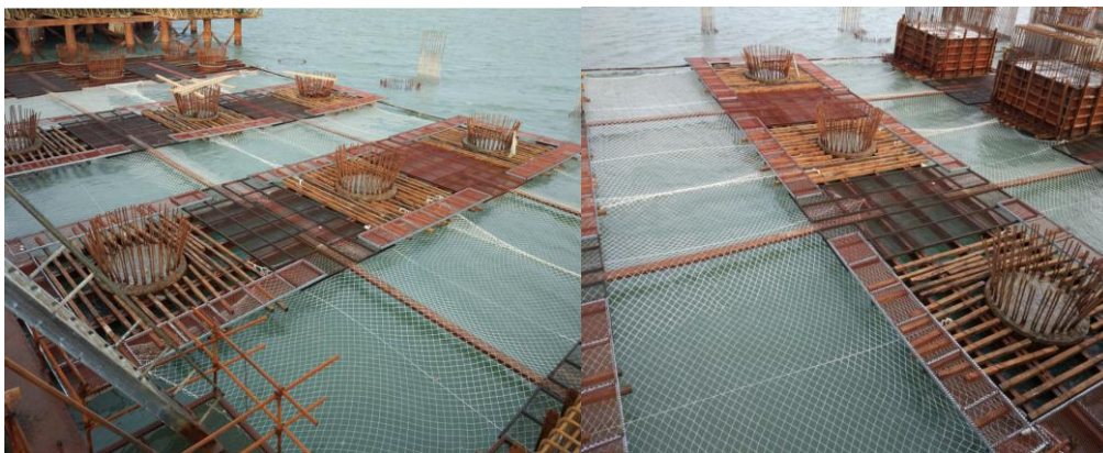
图 4.5-5 桩帽施工操作平台及防护网
