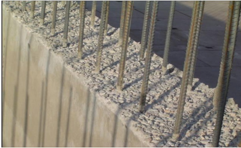
图 3.5-11 沉箱壁施工缝水冲毛处理
