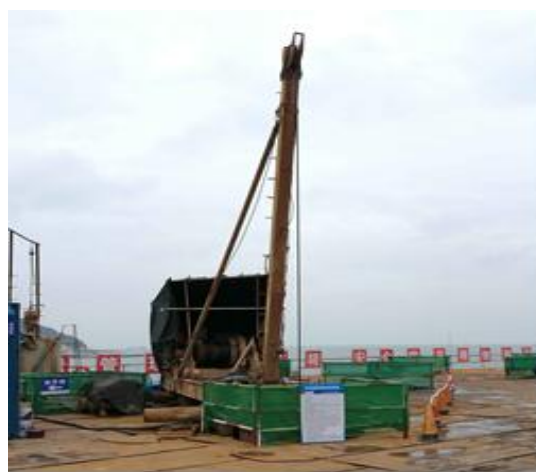
图 4.3-4 施工时安全护栏
