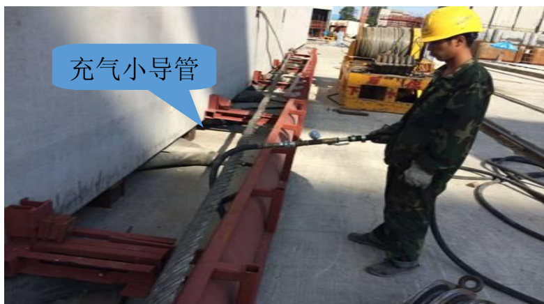
图 3.6-5 气囊充气示意图
