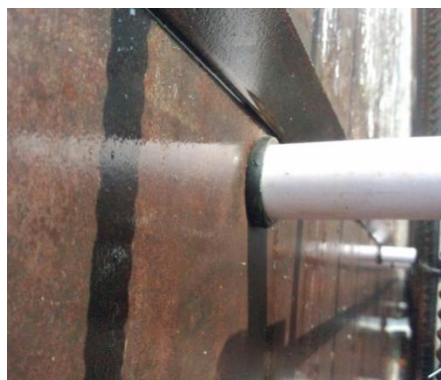
图 2.1-16 PVC 管与模板连接处环形橡胶圈
