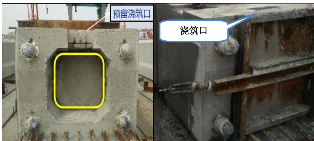
图 4.6-15 安装预制内芯混凝土挡板
