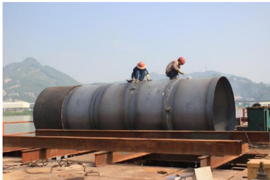
图 4.3-7 小型钢护筒现场制作
