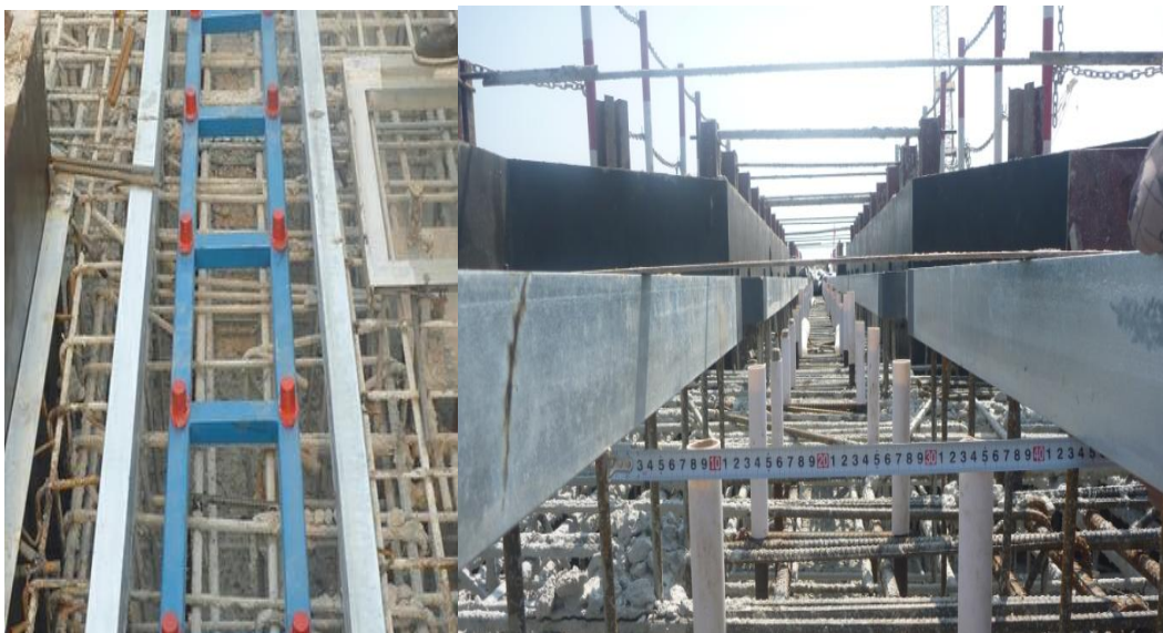
图 2.2-3 固定架安装轨道螺栓
