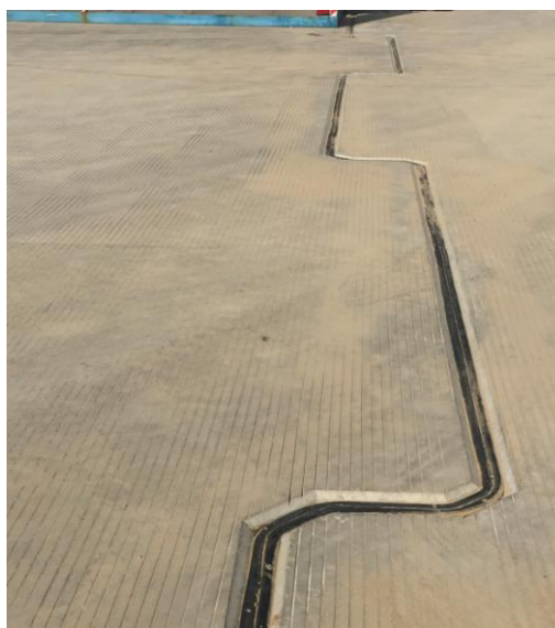
图 4.8-4 结构段间变形缝
