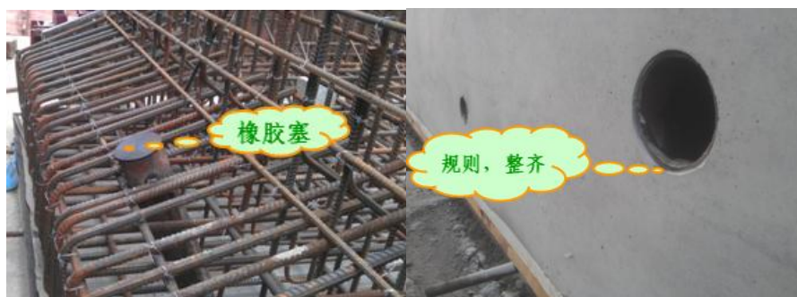
图 3.5-8 高弹性海绵橡胶塞孔口止浆
