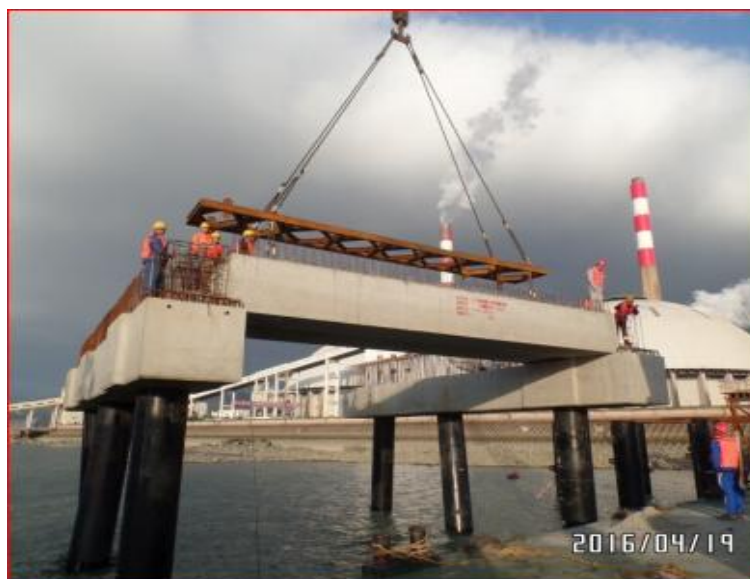
图 4.7-5 采用专用吊具吊装
