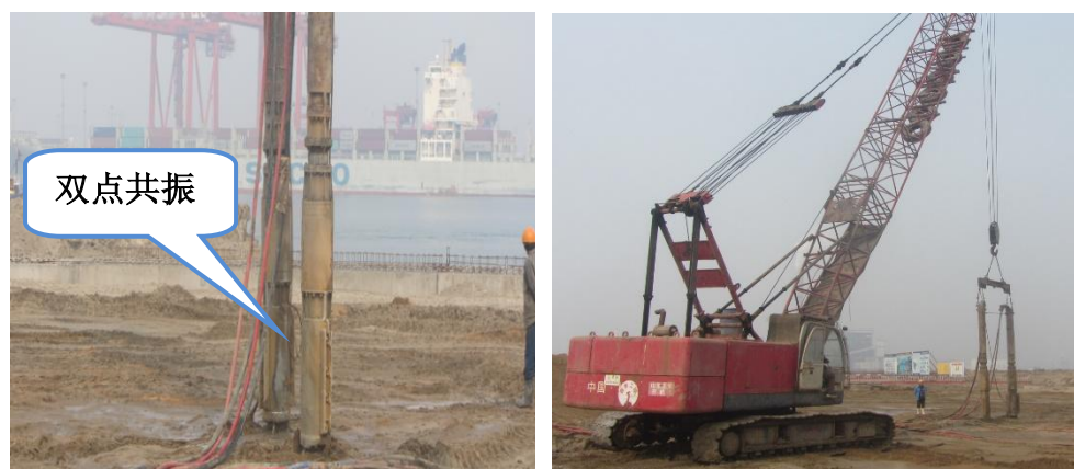
图 5.4-3 地基振冲处理施工
