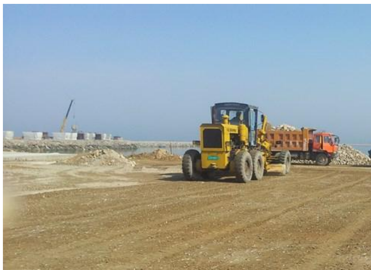
图 2.3-6 级配碎石层平地机整平
