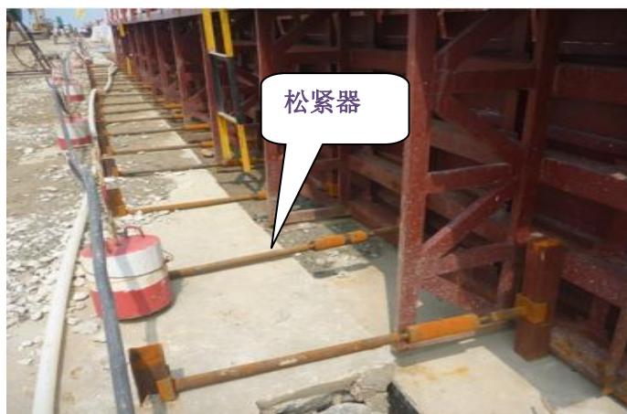
图 2.1-15 松紧器加固模板
