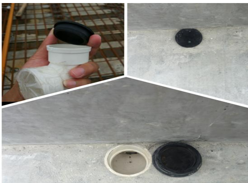
图 2.4-12 排水口橡胶塞工艺
