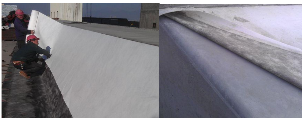
图 3.5-6 前后趾模板粘贴透水模板布
