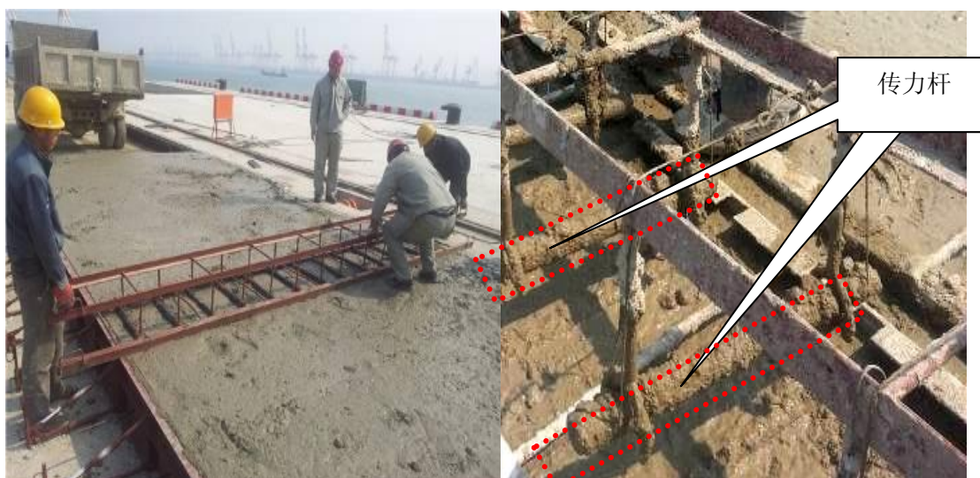
图 2.3-13 限位架配合油丝绳悬吊传力杆安装
