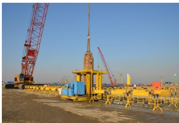
图 5.1-21 接头管起拔
