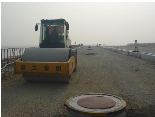
图 2.3-9 井圈混凝土成品保护
