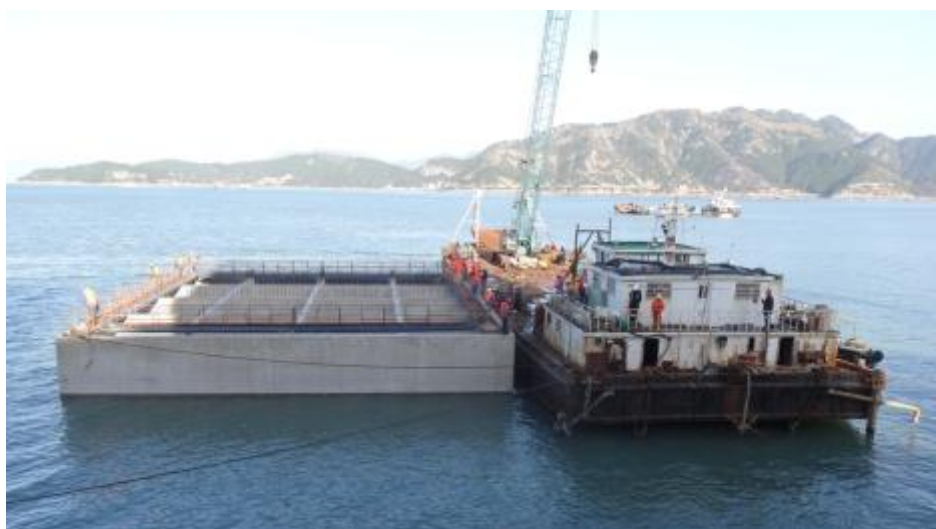
图 3.7-2 驳船定位安装
