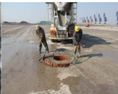
图 2.3-18 逐层砌筑井筒及间隙填筑
