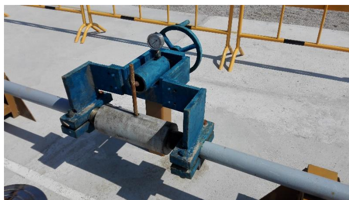
图 5.3-4 剪式恒力仪进行拉杆初始应力检测
