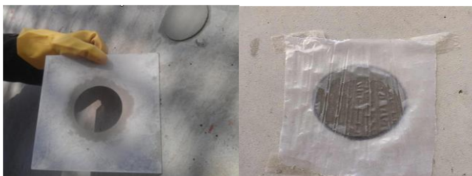
图 2.1-37 圆台螺母封闭示意图
