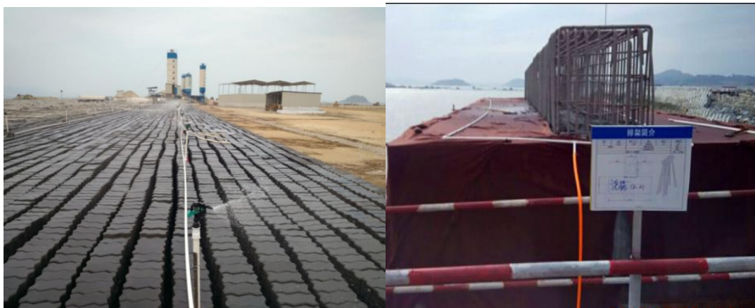
图 2.1-34 联锁块自动喷淋养护
