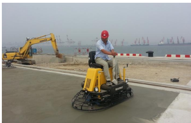
图 2.3-14 驾驶式抹光机抹面
