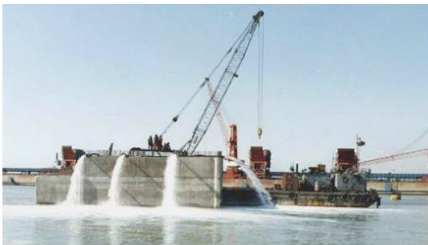
图 3.7-8 沉箱抽水上浮
