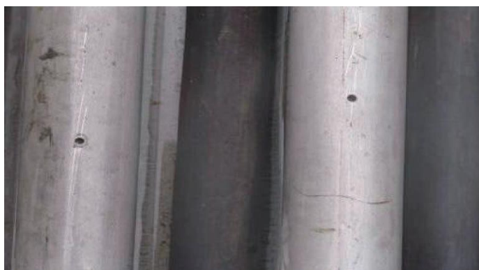
图 2.4-7 不锈钢电缆槽顶部开设排气孔
