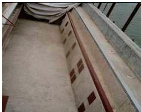
图 2.4-5 电缆管沟预埋件
