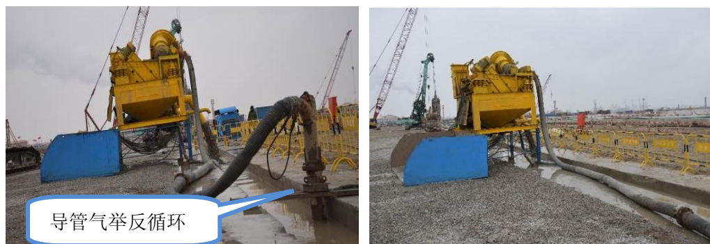
图 5.1-9 导管气举反循环除砂器工艺除砂
