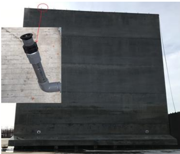
图 2.1-32 沉箱自动喷淋养护
