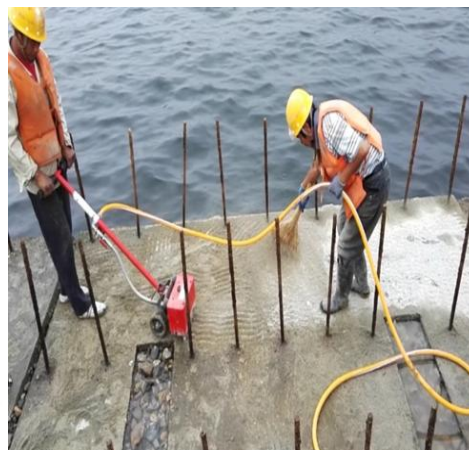
图 2.1-31 手推式凿毛机
