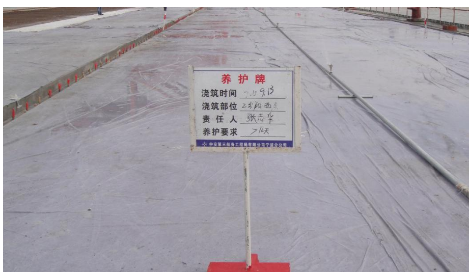
图 2.1-36 码头面层覆盖喷淋养护
