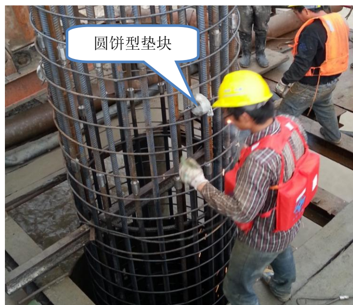
图 4.3-13 钢筋笼安装
