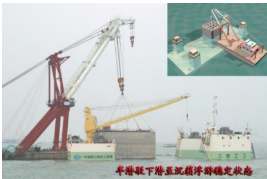
图 3.7-3 半潜驳+起重船助浮安装工艺示意图
