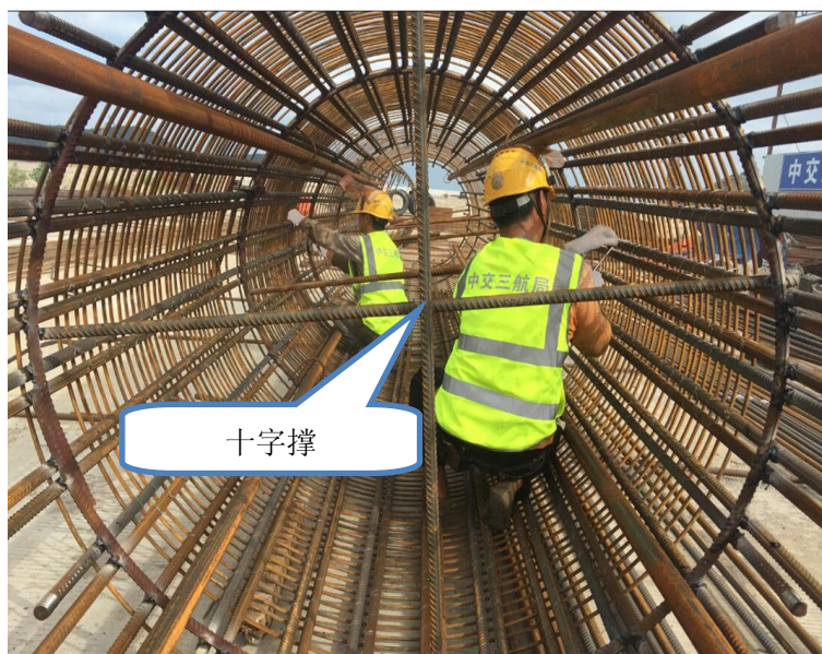
图 4.3-12 钢筋笼增设“十字撑”
