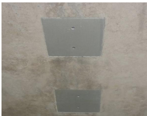
图 2.4-4 两个螺栓固定预埋铁件
