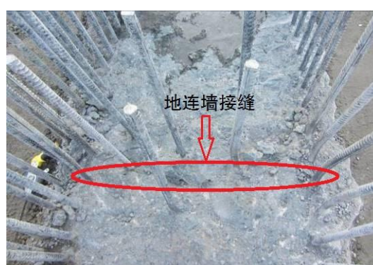
图 5.1-16 接缝顶面凿除后
