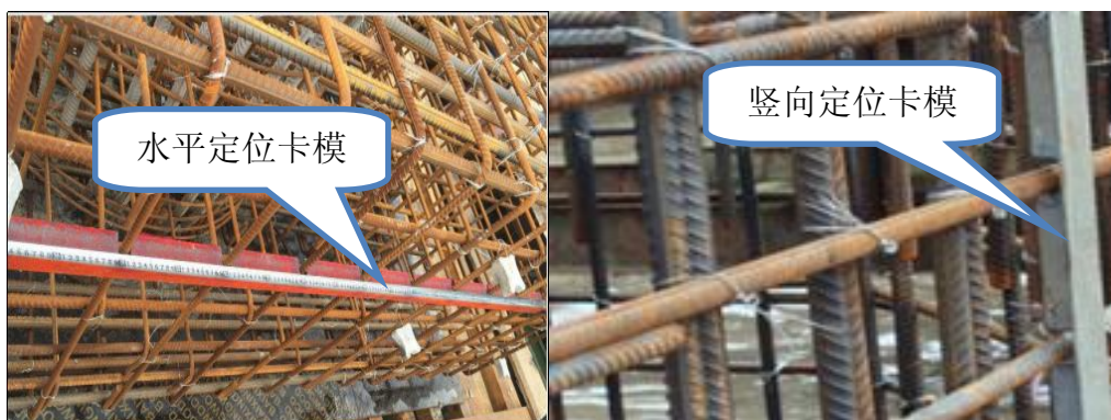
图 4.5-6 竖向、水平角钢定位架
