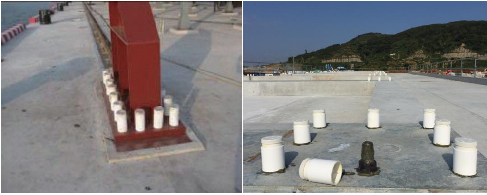
图 2.4-8 预埋件外露螺栓保护
