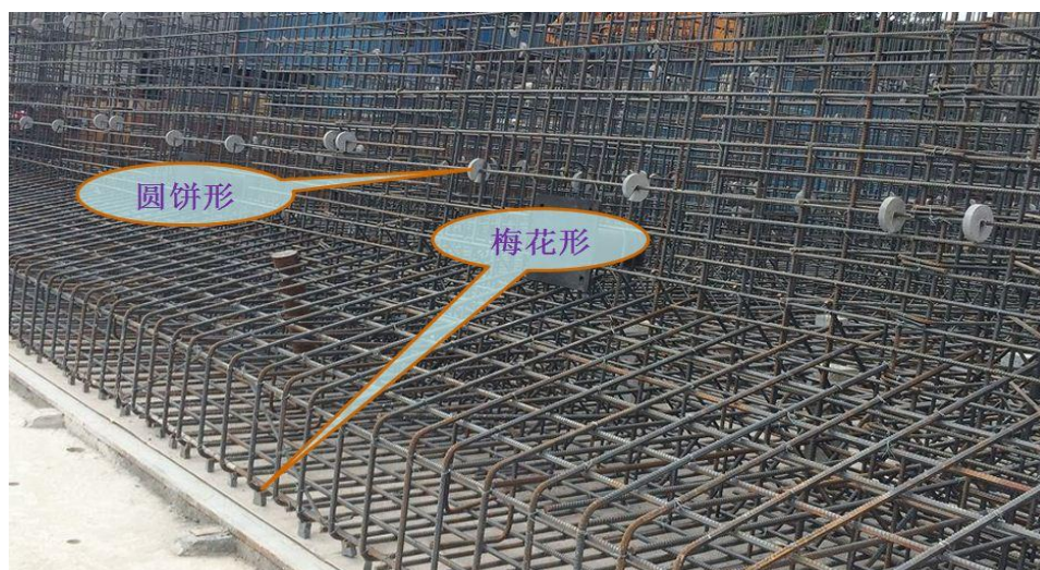
图 2.1-25 梅花形和圆饼形垫块安装
