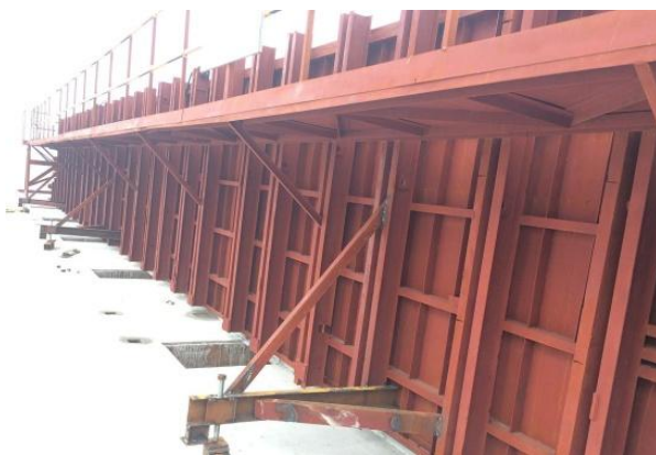
图 2.1-12 底层外模临时固定措施示意图
