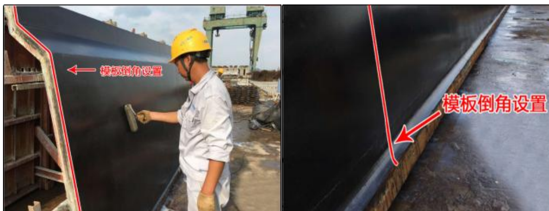
图 4.6-5 预制梁模板无棱化
