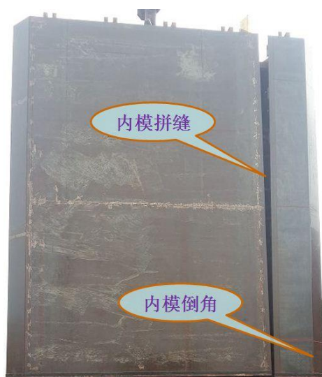
图 3.5-5 内模接缝
