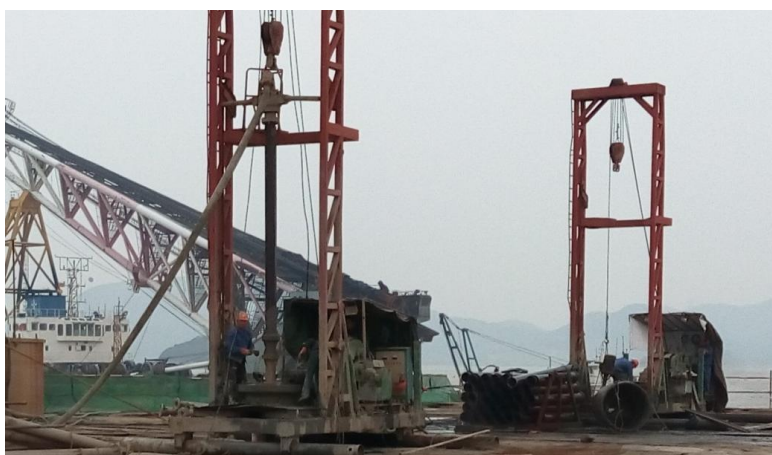
图 4.3-10 成孔施工
