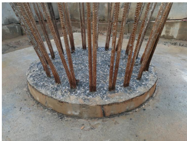
图 4.3-15 灌注桩桩头凿除
