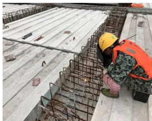
图 4.7-7 面板安装连接加固
