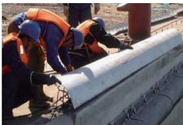
图 2.4-3 护轮坎钢护缘安装
