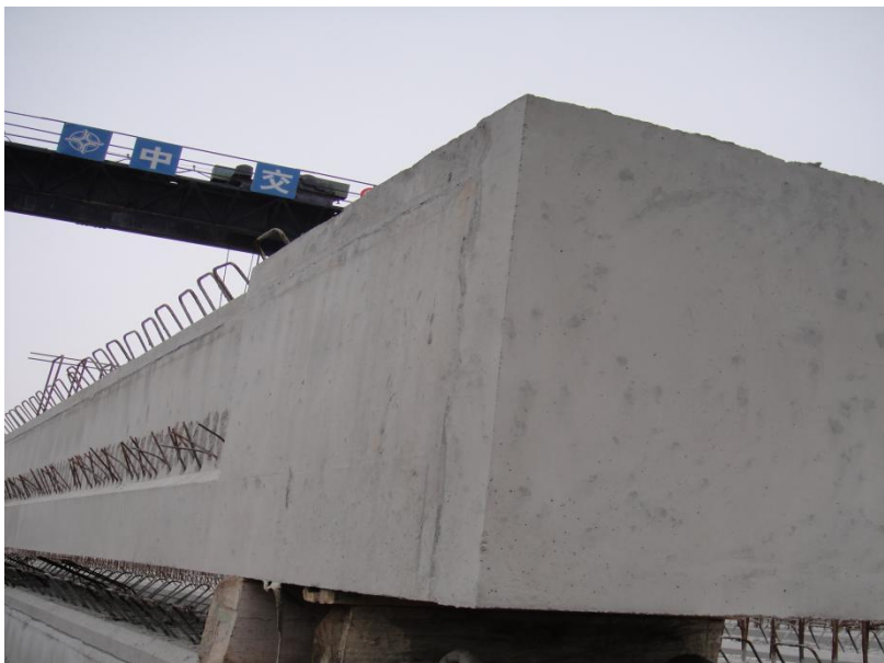
图 2.1-29 封端混凝土
