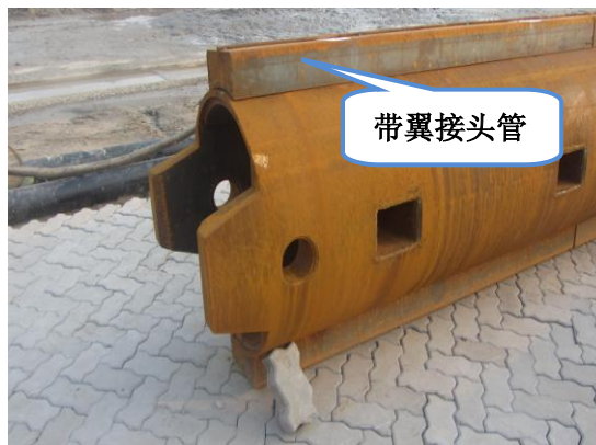
图 5.1-19 加翼接头管
