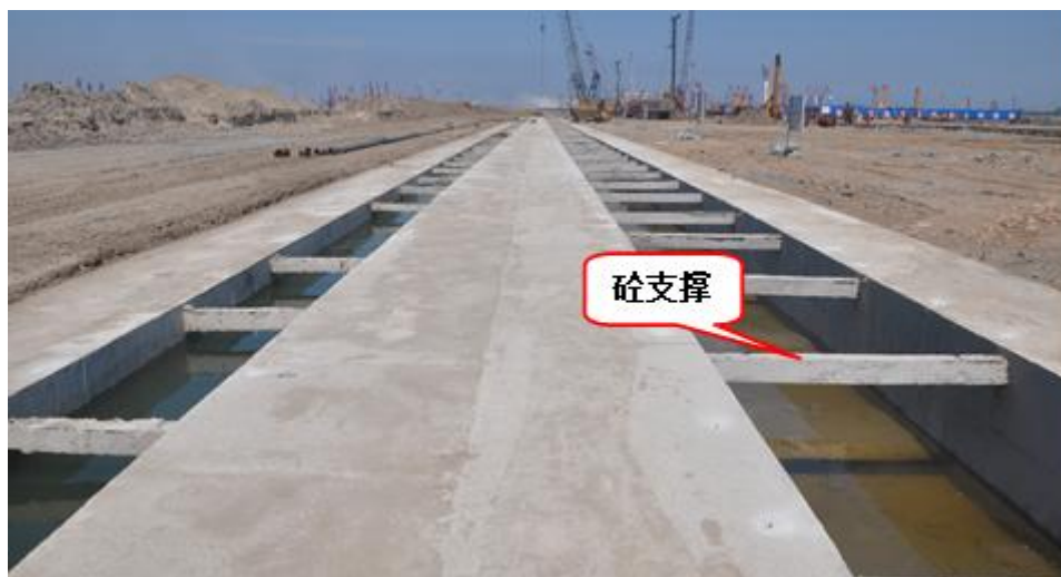
图 5.1-6 导墙支撑
