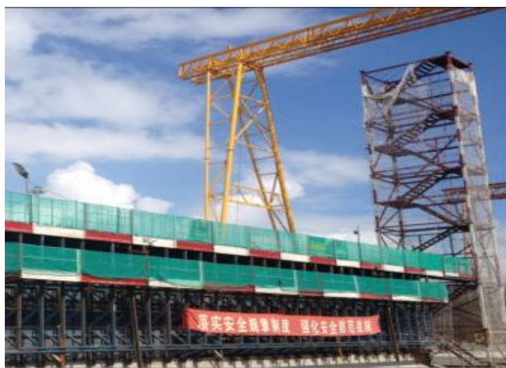
图 2.1-4 操作平台及防护栏杆
