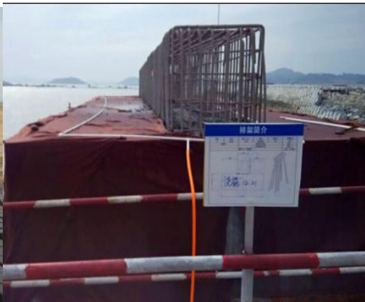
图 2.1-35 横梁覆盖喷淋养护
