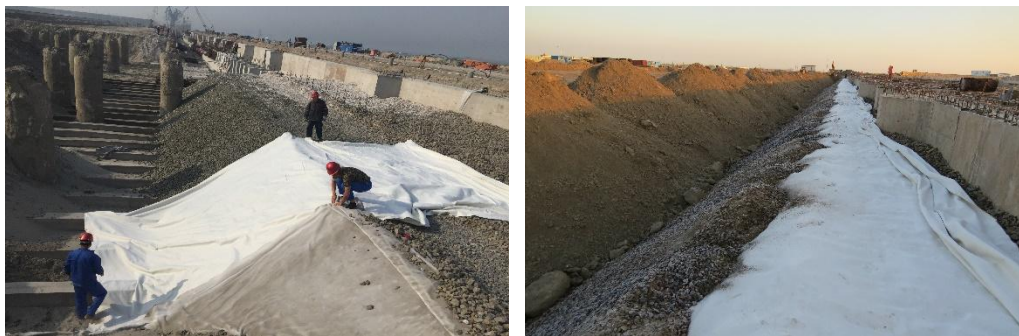
图 5.2-4 倒滤层施工
