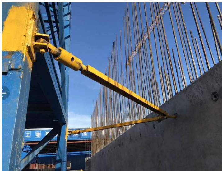
图 3.5-2 塔梯连墙结构
