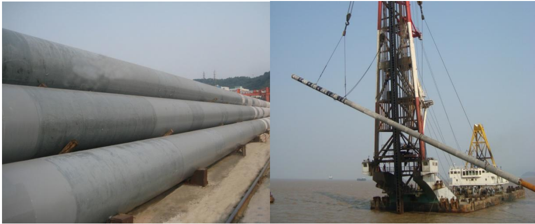
图 4.2-2 管桩驳运、吊运
