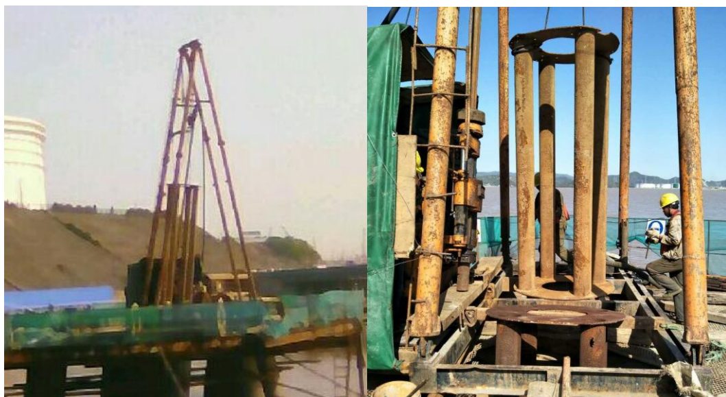
图 4.4-2 下放导向架
