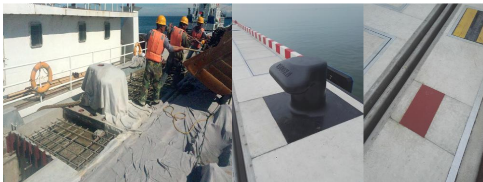
图 3.10-6 系船柱周围混凝土分两次浇筑
