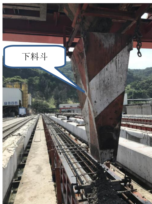
图 4.1-15 混凝土下料斗
