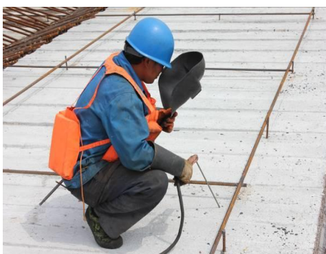
图 4.8-2 现浇面层钢筋标高定位架
