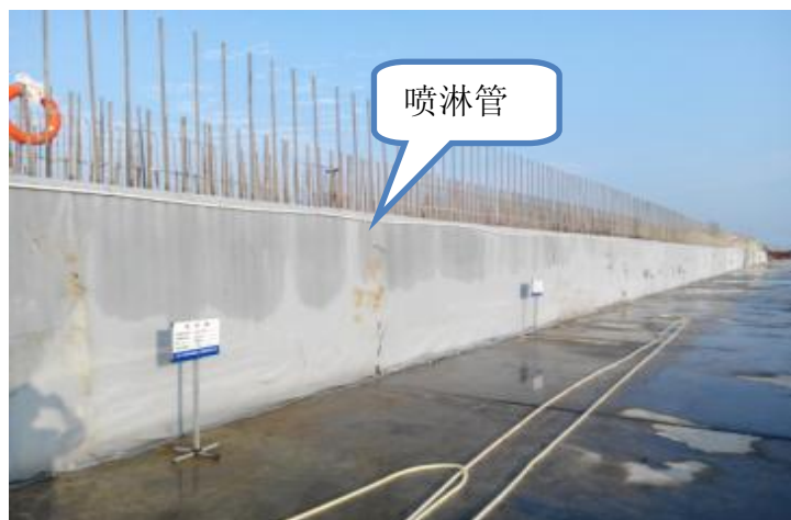
图 3.10-8 混凝土覆盖养护示意图
