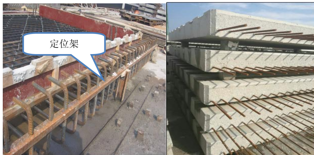
图 4.6-1 弯起钢筋限位卡槽
