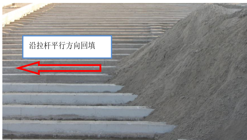
图 5.4-2 土方回填施工
