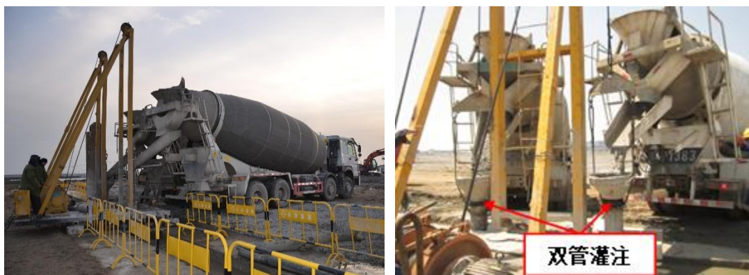
图 5.1-30 地连墙混凝土浇筑
