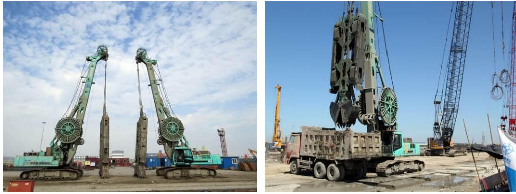
图 5.1-2 液压抓斗成槽施工
