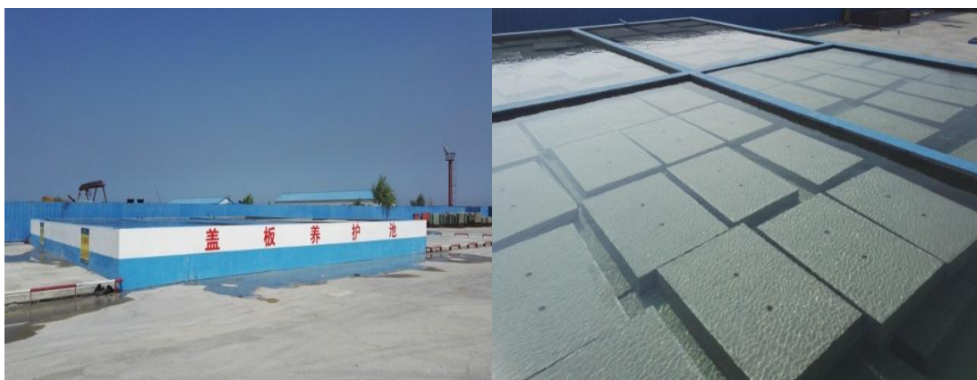
图 2.1-33 小型构件养护池浸泡养护
