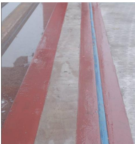
图 3.10-7 变形缝采用橡胶板填充示意图
